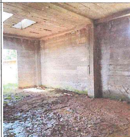
Fotografía n.º 26: En la vista se observó la inyección de falso piso y contrapiso en el ambiente de casa de fuerza.
