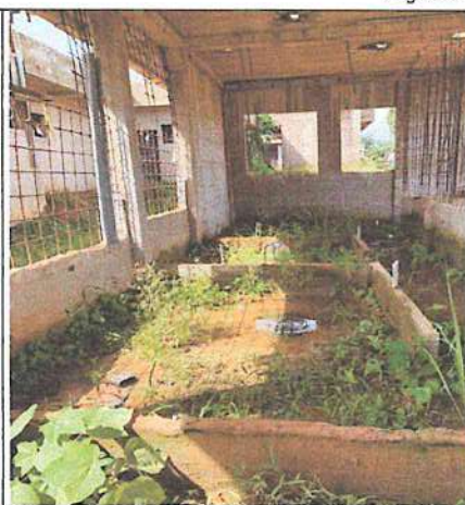
Fotografía n.º 18: En la vista se observó la inyección de falso piso y contrapiso en el ambiente de la UPS Prevención y Control TBC.
