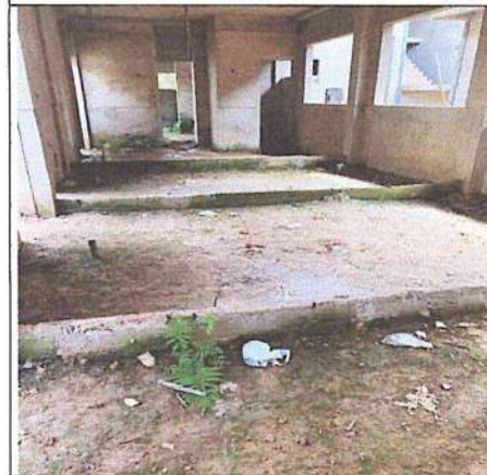
Fotografía n.º 21: En la vista se observó la inyección de falso piso y contrapiso en el ambiente de consultorios.
