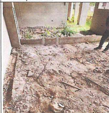
Fotografía n.º 20: En la vista se observó la inyección de falso piso y contrapiso en el ambiente de la UPS casa materna.
