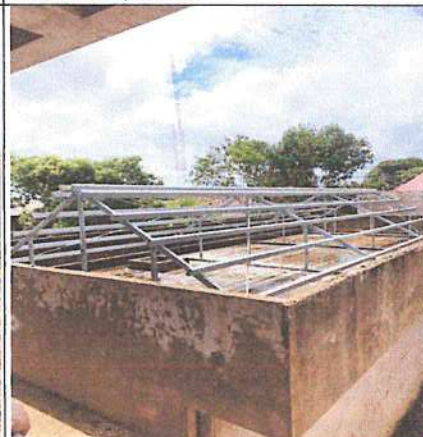
Fotografía n.º 14: En la vista se observó la inyección de cobertura y cumbrera en la UPS casa materna.
