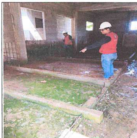
Fotografía n.º 23: En la vista se observó la inyección de falso piso y contrapiso en el ambiente de ecografía y radiología.
