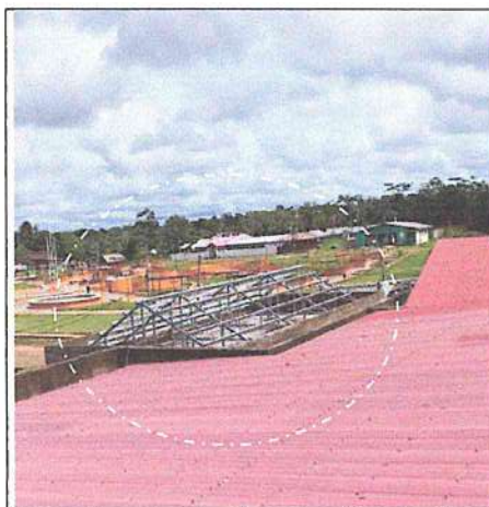
Fotografía n.º 17: En la vista se observó la inyección de cobertura y cumbra en el ambiente de la UPS Prevención y Control TBC.
