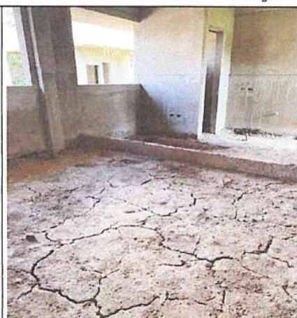
Fotografía n.º 24: En la vista se observó la inyección de falso piso y contrapiso en el ambiente de emergencia.
