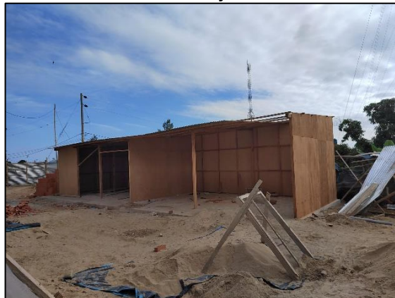
Imagen n.º 1 Vista de estructura de madera y triplay instalándose en la parte posterior de los módulos 5 y 6 de la Obra
