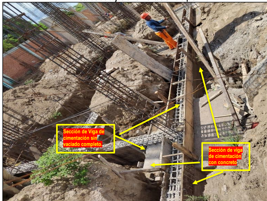
Imagen n.º 2 Vista de trabajos en cimentación bloque I
