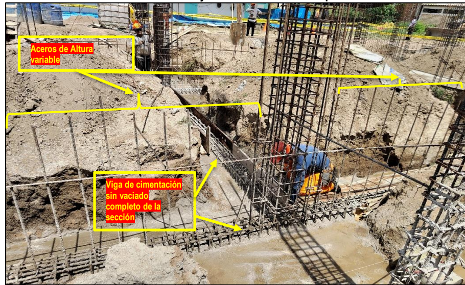
Imagen n.º 2 Vista de trabajos en cimentación bloque I
