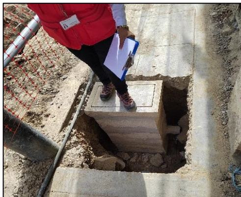
Imagen n.º 35 Buzones de agua domiciliarios con excavación expuesta en calle Mayos Novoa
