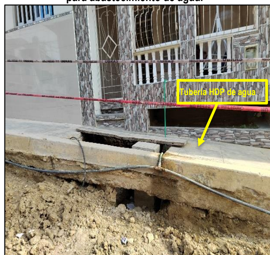
Imagen n.º 19 Cerco de seguridad en calle Mayor Novoa y tubería HDP para abastecimiento de agua.
