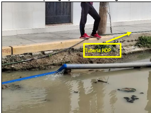
Imagen n.º 21 Tubería HDP para agua potable en calle Jorge Herrera.
