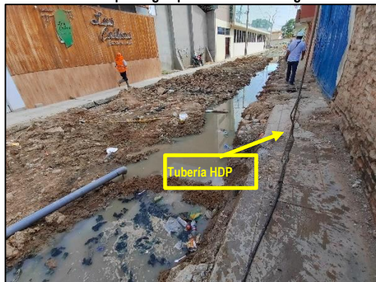
Imagen n.º 22 Tubería HDP para agua potable en calle Jorge Herrera.
