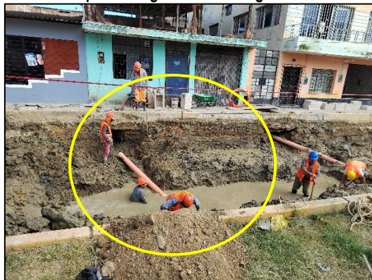
Imagen n.º 39 Ejecución de trabajos de instalación de tuberías de PVC SAP para desagüe en Calle Jorge Herrera
