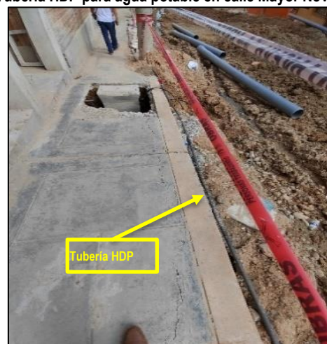
Imagen n.º 20 Cerco de seguridad en calle Mayor Novoa y tubería HDP para abastecimiento de agua.
