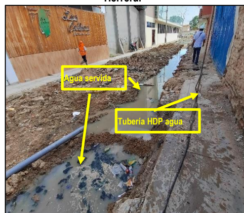
Imagen n.º 5 Tubería HDP para agua potable en calle Jorge Herrera.
