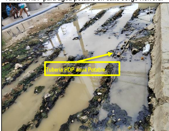
Imagen n.º 15 Tubería HDP para agua potable en calle Jorge Herrera.
