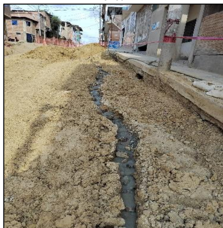
Imagen n.º 11 Recorrido del agua servida por la calle Mayor Novoa.
