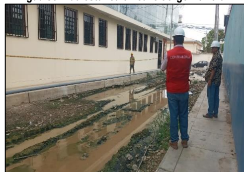
Imagen n.º14 Agua servida estanca en calle Jorge Herrera
