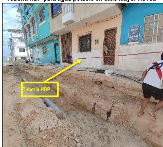
Imagen n.º 19 Cerco de seguridad en calle Mayor Novoa y tubería HDP para abastecimiento de agua.
