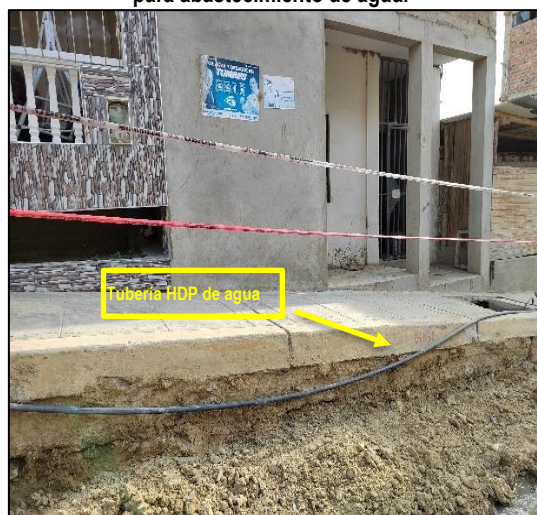
Imagen n.º 20 Cerco de seguridad en calle Mayor Novoa y tubería HDP para abastecimiento de agua.
