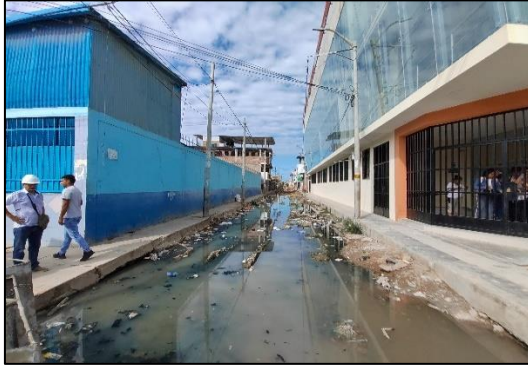
Imagen n.º 33 Falta de cerco de seguridad lado derecho en calle Jorge Herrera, en final de tramo.
