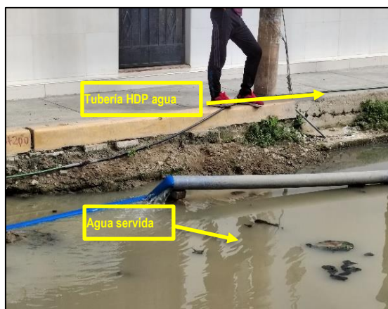
Imagen n.º 4 Tubería HDP para agua potable en calle Jorge Herrera.
