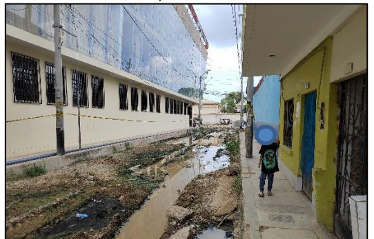
Imagen n.º 34 Falta de cerco de seguridad lado derecho en calle Jorge Herrera, en final de tramo
