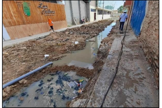
Imagen n.º 34 Falta de cerco de seguridad lado derecho en calle Jorge Herrera, en final de tramo
