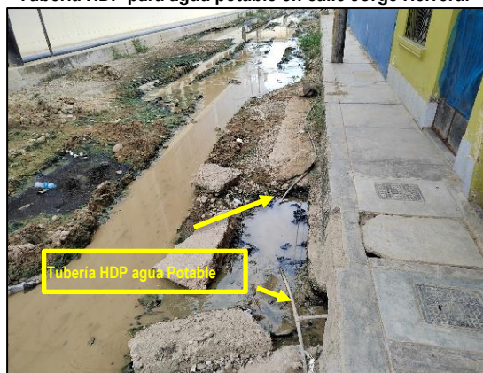
Imagen n.º 16 Tubería HDP para agua potable en calle Jorge Herrera.
