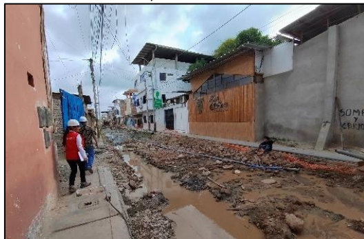
Imagen n.º 33 Falta de cerco de seguridad lado derecho en calle Jorge Herrera, en final de tramo.
