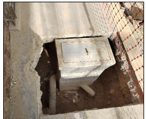
Imagen n.º 36 Buzones de agua domiciliarios con excavación expuesta en calle Mayor Novoa
