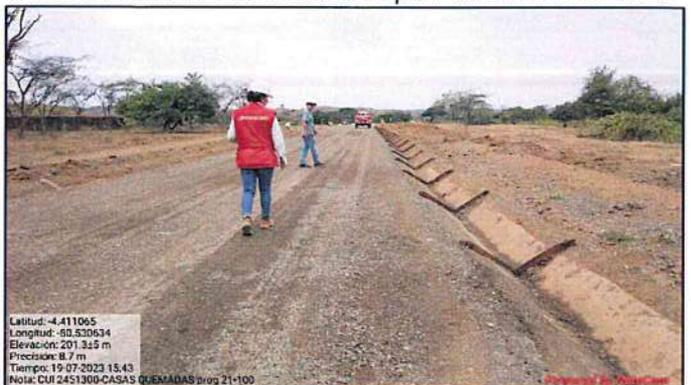
**Fotografía n.º 106:** Desde progresiva 21+100 se encuentran trabajos en la ejecución de la partida 04.01.02 Construcción de cunetas revestidas: Acabado en paños de cunetas.
