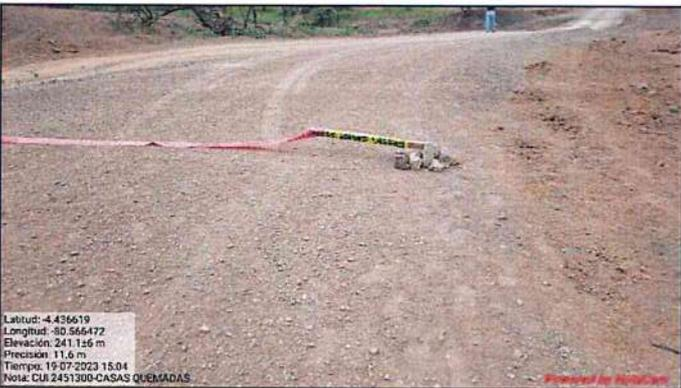
**Fotografía n.º 93:** Aprox. Progresiva 15+021 se encuentra el badén N°9, no tiene emboquillado de entrada ni de salida.
