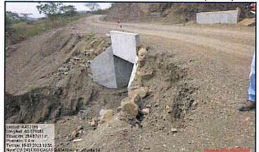
**Fotografía n.º 7:** Aprox. Progresiva 13+218 se encuentra alcantarilla N°15, estructura completa.
