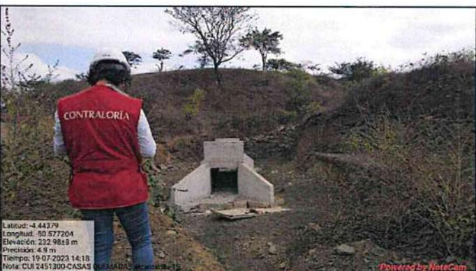
**Fotografía n.º 71:** Aprox. Progresiva 13+218 se encuentra alcantarilla N°15, no tiene emboquillado de entrada ni de salida.
