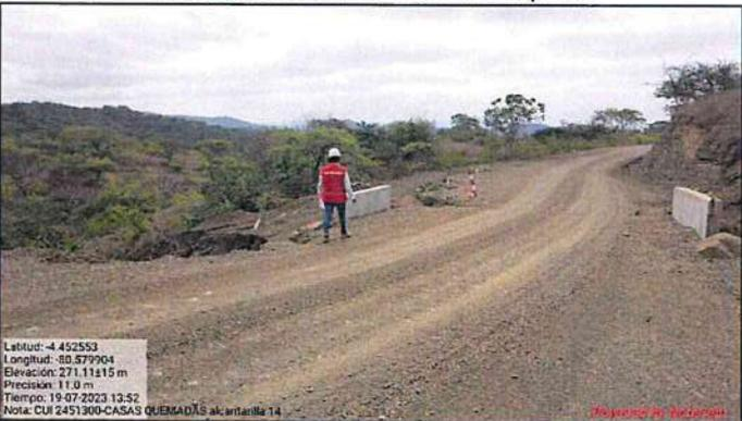
**Fotografía n.º 59:** Aprox. Progresiva 11+780 se encuentra alcantarilla N°14, no tiene emboquillado de entrada ni de salida y presenta erosión de talud sobre aleros (salida)
