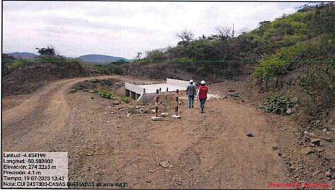
**Fotografía n.º 55:** Aprox. Progresiva 11+550 se encuentra alcantarilla N°13, no tiene emboquillado de entrada ni de salida y presenta erosión de talud sobre aleros.
