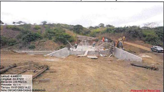
**Fotografía n.º 77:** En alcantarilla multiplate N°3 se realizan trabajos de encofrado de pantallas.
