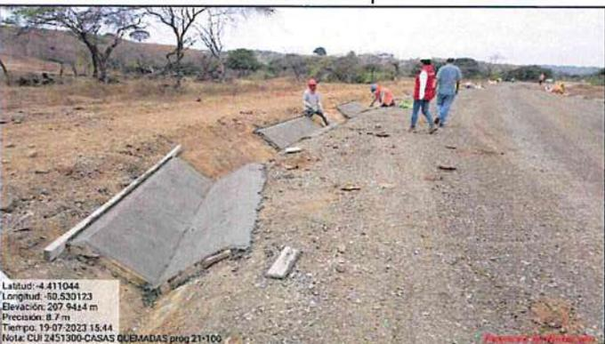
**Fotografía n.º 107:** Desde progresiva 21+100 se encuentran trabajos en la ejecución de la partida 04.01.02 Construcción de cunetas revestidas: Acabado en paños de cunetas.
