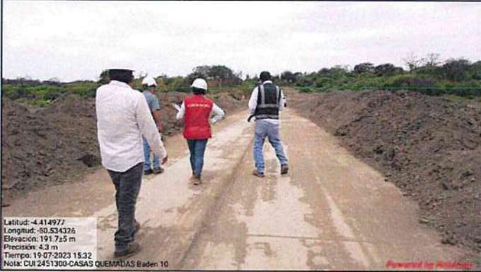
**Fotografía n.º 103:** Aprox. Progresiva 20+500 se encuentra el badén N°10, el cual quedó completamente colmatado con el evento lluvioso.
