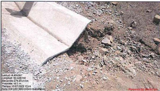
**Fotografía n.º 33:** En aprox. Progresiva 3+900 los extremos de cunetas están erosionadas.
