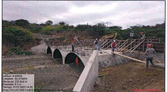
**Fotografía n.º 80:** Aprox. Progresiva 13+740 se encuentra alcantarilla multiplate N°3, acero habilitado.
