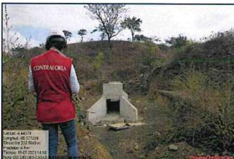
**Fotografía n.º 8:** Aprox. Progresiva 13+242 no se encuentra la alcantarilla N°16. Se visualiza acero habilitado en estado de oxidación.
