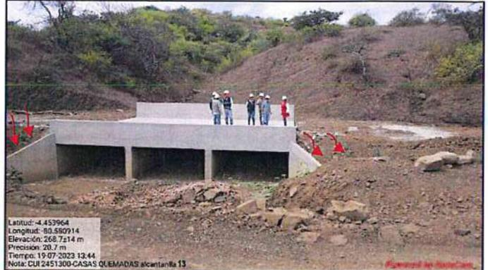
**Fotografía n.º 56:** Aprox. Progresiva 11+722 se encuentra el badén N°6, no tiene emboquillado de entrada ni de salida, tiene juntas de dilatación sin sellar y está sedimentado.
