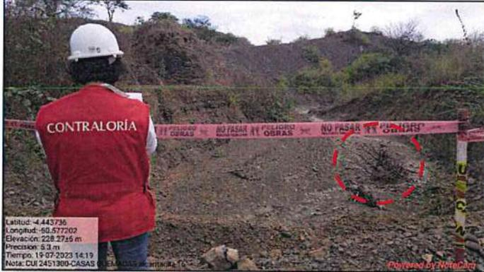
**Fotografía n.º 73:** Aprox. Progresiva 13+383 se encuentra alcantarilla N°17, estructura completa, no tiene emboquillado de entrada ni de salida.
