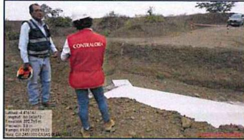
**Fotografía n.º 18:** Aprox. Progresiva 21+560 visualiza área donde se construirá la alcantarilla N°26. Asimismo, se verifica la base compactada de la vía.
