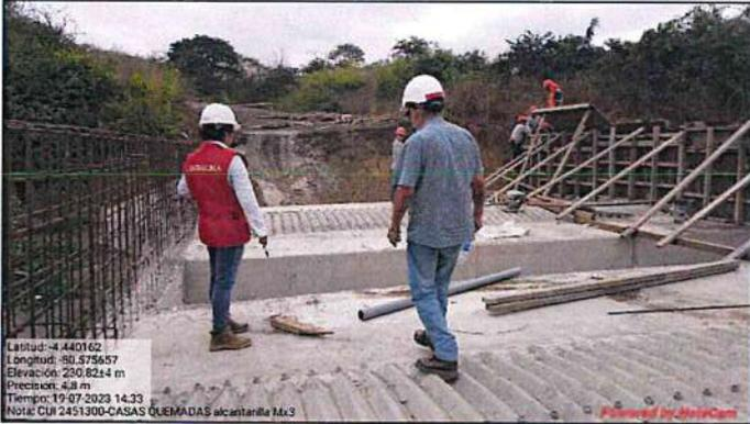
**Fotografía n.º 79:** Aprox. Progresiva 13+740 se encuentra alcantarilla multiplate N°3, no tiene emboquillado de entrada ni de salida.
