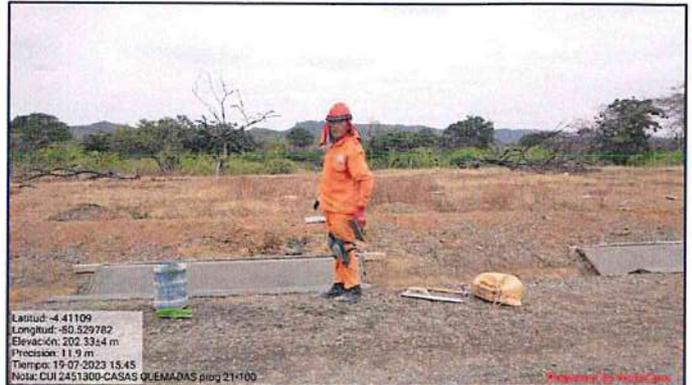
**Fotografía n.º 110:** Desde progresiva 21+100 se encuentran trabajos en la ejecución de la partida 04.01.02 Construcción de cunetas revestidas: Cunetas curadas con aditivo químico.
