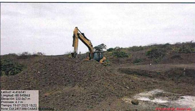
Fotografía n.º 101: Aprox. Progresiva 20+500 se encuentra el badén N°10, L=120m, con acumulacion de material a los costados producto de la remoción de material sedimentado producto del periodo lluvioso.
