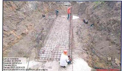
**Fotografía n.º 11:** Aprox. Progresiva 13+873 se encuentra alcantarilla N°19, realizando trabajos vaciado de concreto en muros y aleros.
