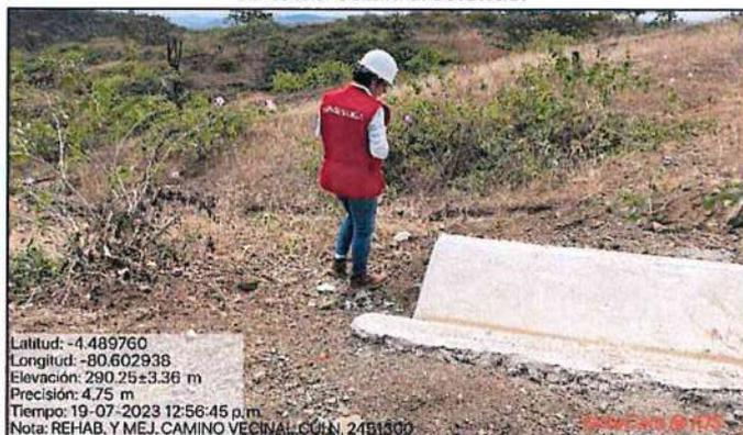
**Fotografía n.º 34:** En aprox. Progresiva 5+520 se visualizan cunetas a ambos lados.
