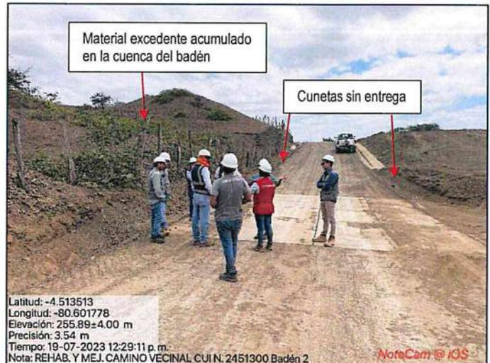
**Fotografía n.º 22:** El badén N°2 tiene juntas de dilatación sin sellar y no tiene emboquillado de ingreso ni de salida.
