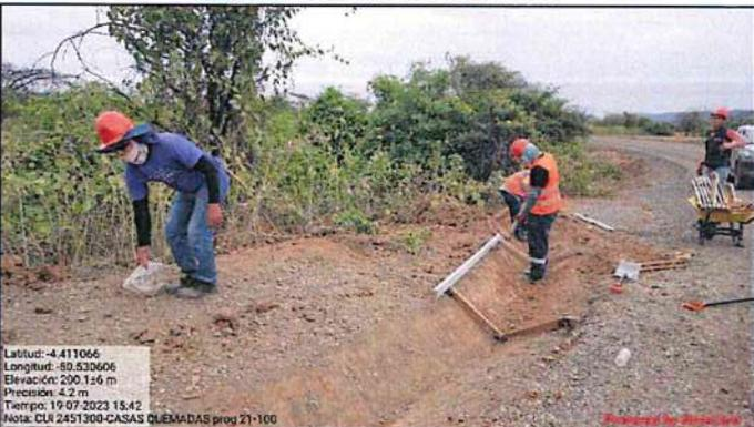
**Fotografía n.º 105:** Desde progresiva 21+100 se encuentran trabajos en la ejecución de la partida 04.01.02 Construcción de cunetas revestidas: zona habilitada para vaciado de concreto.
