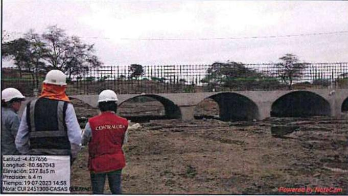
**Fotografía n.º 91:** Aprox. Progresiva 14+919 se encuentra alcantarilla N°23, se visualiza excavación y trazo y replanteo.
