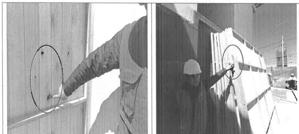
Imagen n.º8: Presencia de agujeros en la madera machihembrada – modulo 2
