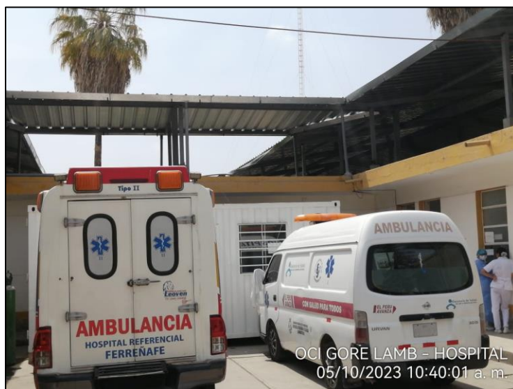
Imagen n.º 021 Cobertura Instalada en el Hospital Referencial de Ferreñafe
