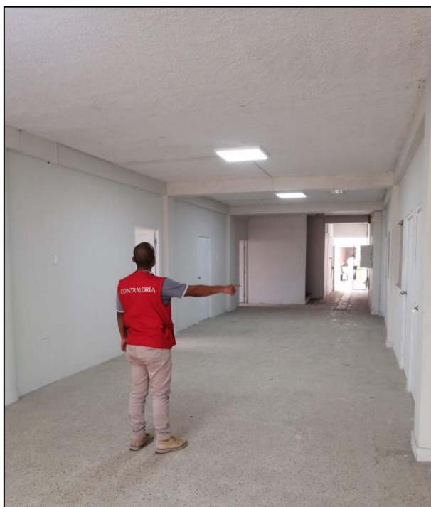
Imagen n.º 014 Consultorios de drywall instalados en el primer nivel del local donde se ejecutará el Plan de Contingencia Red de Salud
