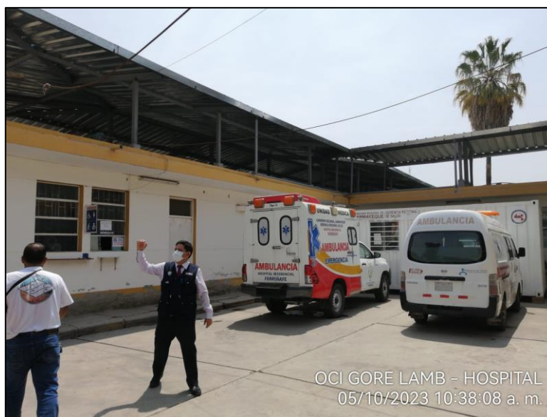
Imagen n.º 020 Cobertura Instalada en el Hospital Referencial de Ferreñafe
