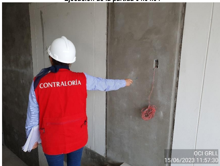
Imagen n.º 27 Ejecución de la partida 04.04.04
