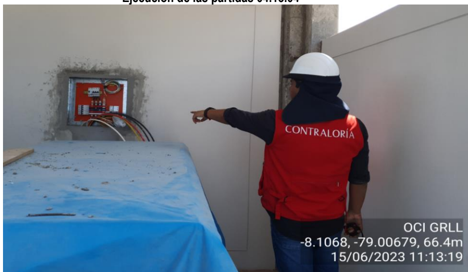
Imagen n.º 29 Ejecución de las partidas 04.13.04
