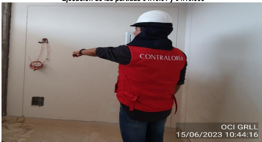
Imagen n.º 28 Ejecución de las partidas 04.10.01 y 04.10.003
