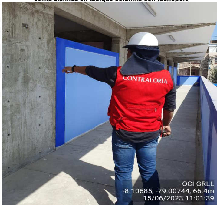
Imagen n.º 49 Módulo 3 Junta sismica en tabique columna con tecnoport
