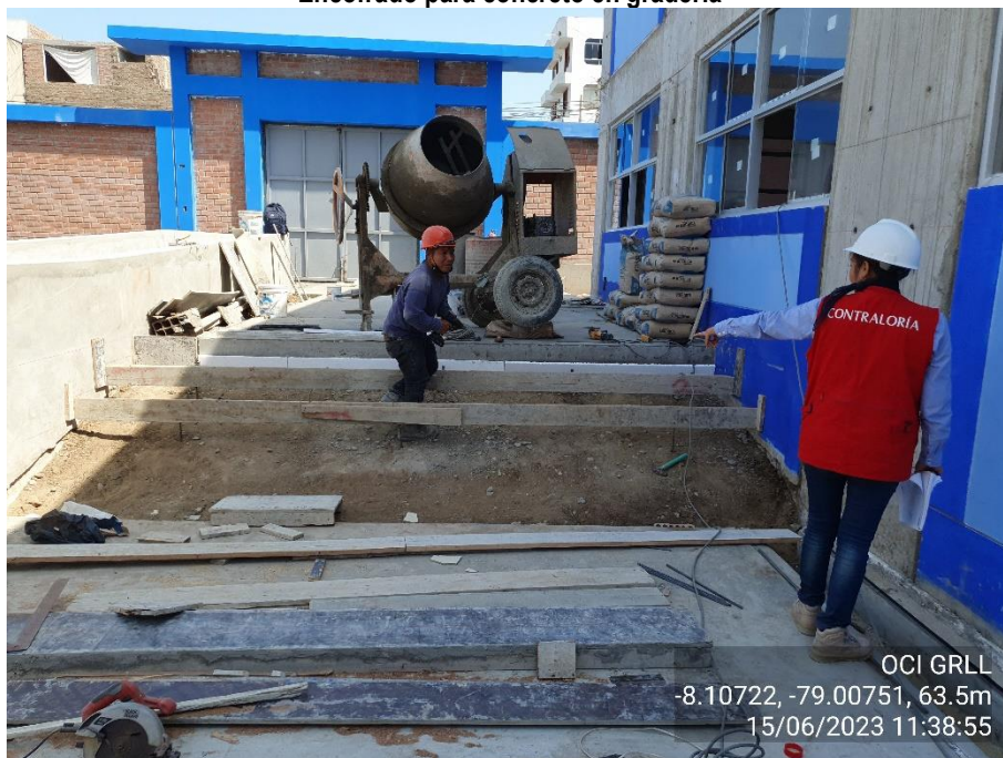
Imagen n.º 51 Encofrado para concreto en gradería
