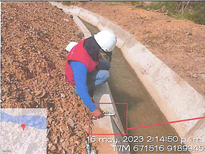
Se observa el asentamiento de un paño del revestimiento de concreto del canal.
