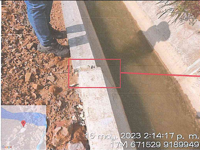
Se observa el asentamiento de un paño del revestimiento de concreto del canal.
