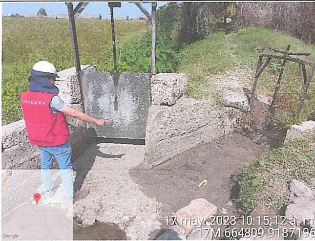
Se observó dos (2) compuertas preexistentes.
