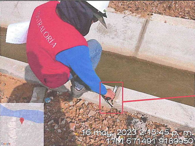
Se observa el asentamiento de un paño del revestimiento de concreto del canal.
