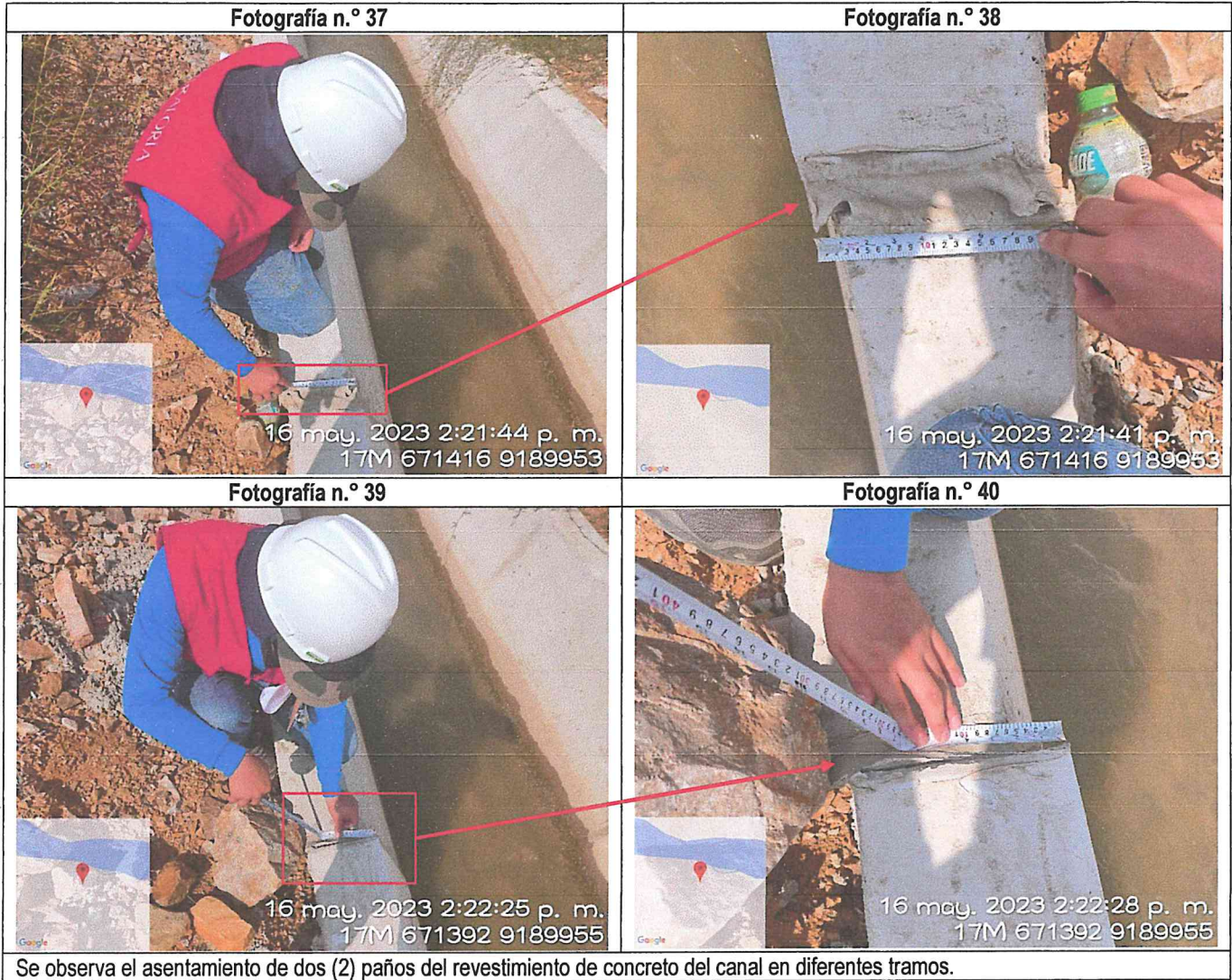
Se observa el asentamiento de dos (2) paños del revestimiento de concreto del canal en diferentes tramos.
