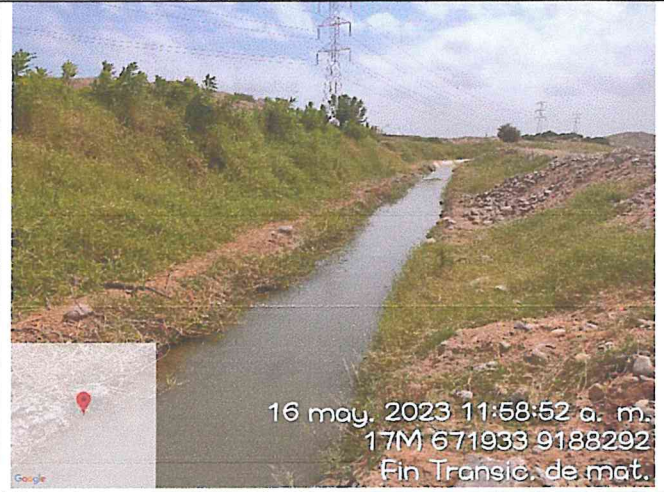
Se observa tramo pendiente de ejecutar.
