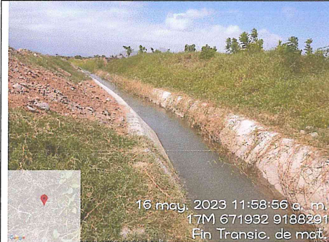
Se observa parte del revestimiento construido en el canal.
