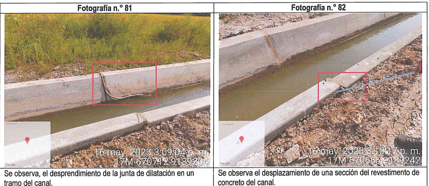
Se observa, el desplazamiento de una sección del revestimiento de concreto del canal.
