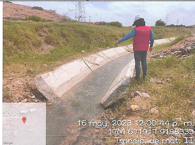
Se observa el revestimiento de concreto de otro tramo del canal.
