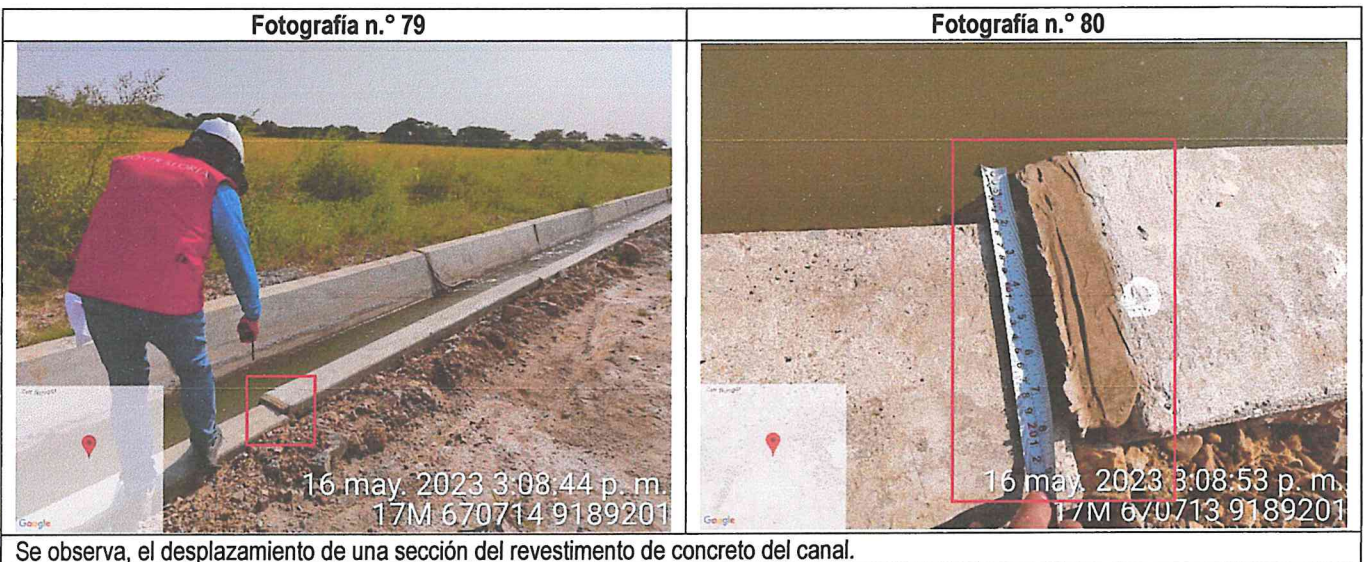
Se observa, el desplazamiento de una sección del revestimiento de concreto del canal.
