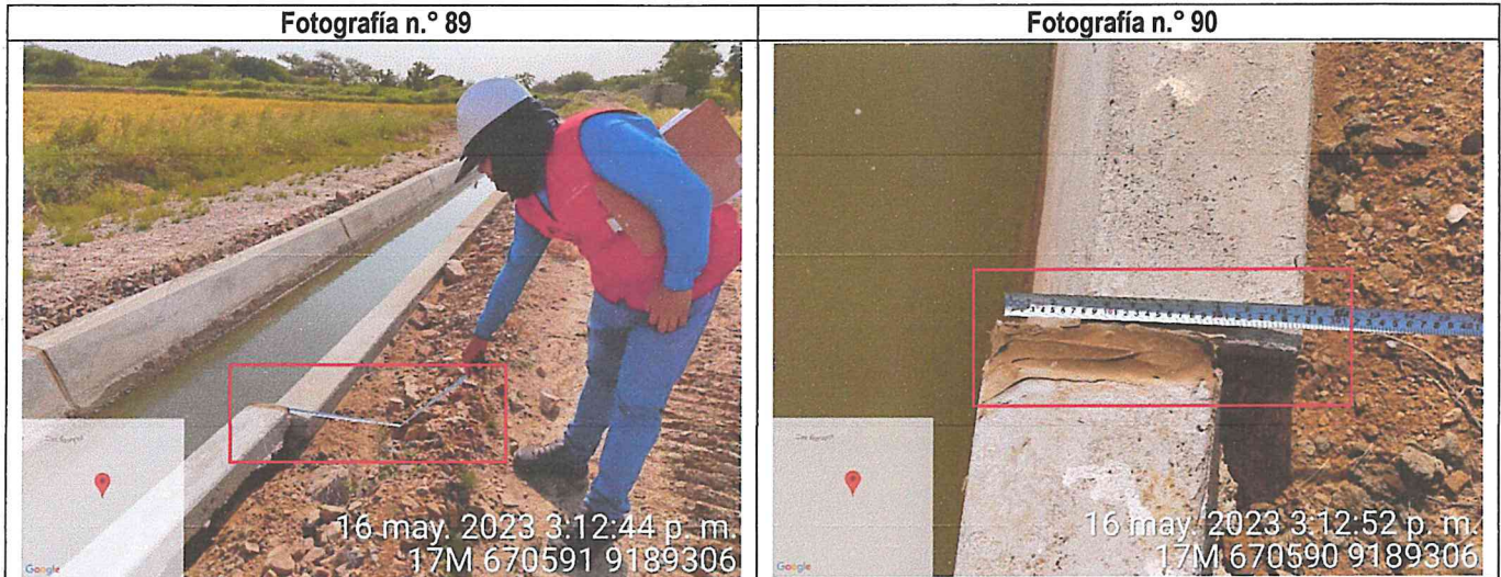
Se observa el desplazamiento de una sección del revestimiento de concreto del canal.
