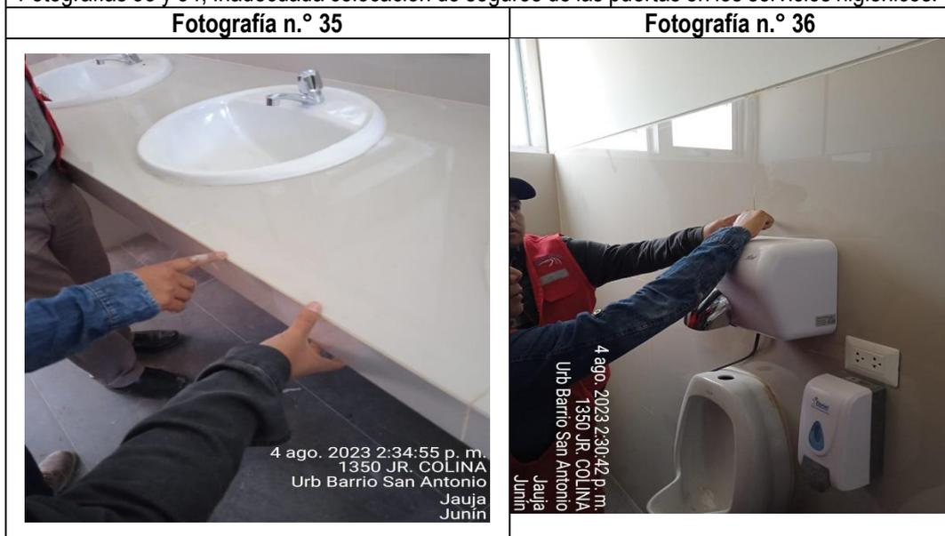
Fotografías 35 y 36, se observa Inadecuada instalación de cerámico en dos puntos de los servicios higiénicos.
