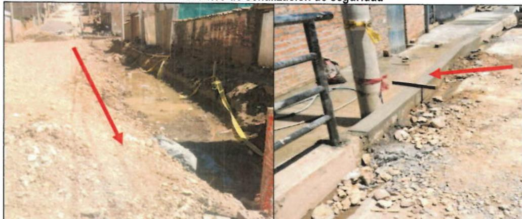
**Imagen n.º 3:** En el Jr. Túpac Amaru se observa excavaciones para la ejecución de sistema de drenaje las cuales no cuenta con señalización, generando riesgo a la población.
