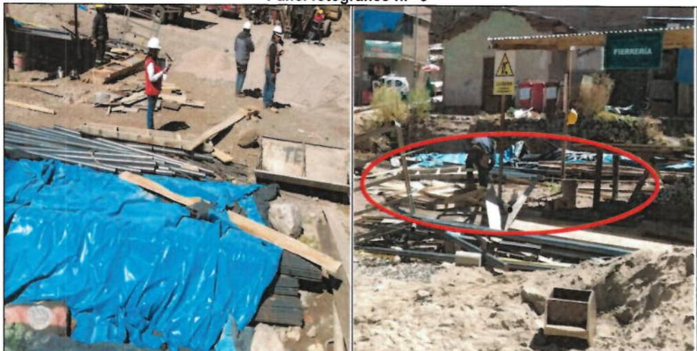
Imagen n.º 11: Se observa el inadecuado almacenamiento de tuberías de metal y acero corrugado, no presentan el orden adecuado para su conteo y se encuentran expuestas a la intemperie.
