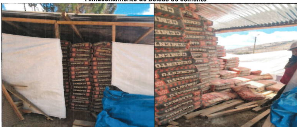
Imagen fotográfica n.º 3: Se observa bolsas de cemento de marca Inka tipo I, almacenados en pilas de 17 bolsa.
