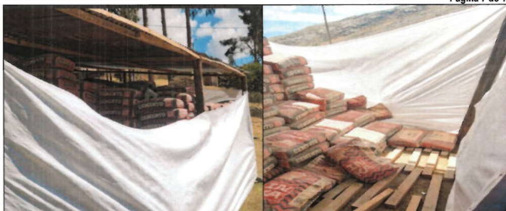
Imagen fotográfica n.º 5: Se observa bolsas de cemento marca Inka tipo I, cubierta parcialmente expuesta a posibles precipitaciones propias a la estación donde se ubica la obra.
