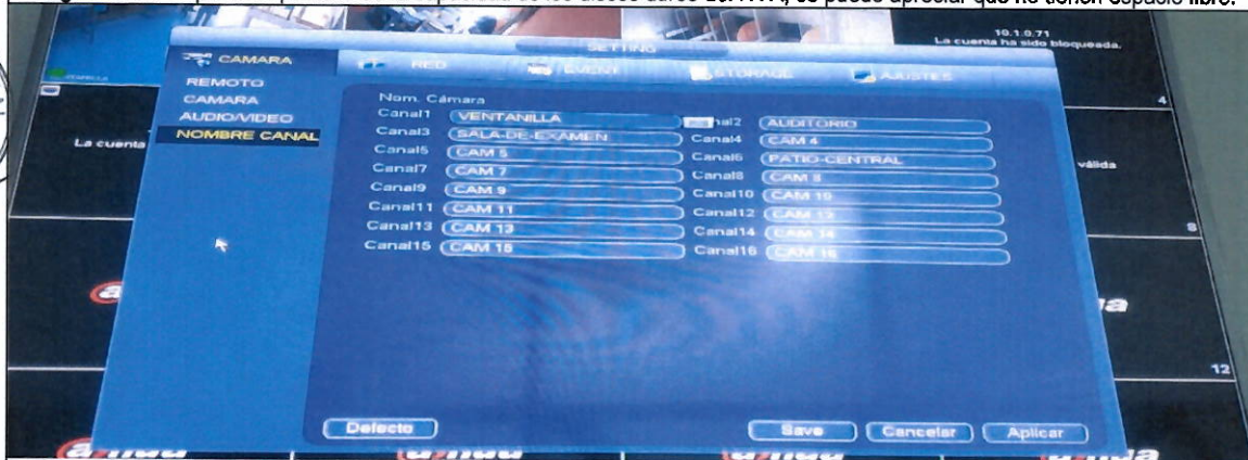
Imagen n.º23: Captura de pantalla del NVR con la configuración de canales de las Cámaras de video -se aprecia el Canal 3 – SALA DE EXAMEN.
