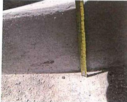
Se evidenció la altura del canal de drenaje alrededor del reservorio en el Sector la Lucma es de 20 cm, y la pared del mismo tiene un ancho de 10 cm.
