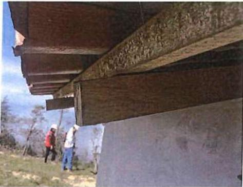
Se evidenció correas de 2"x2" y viguetas de 2"x3" de madera sin ningún acabado en UBS 1871 y 1876.
