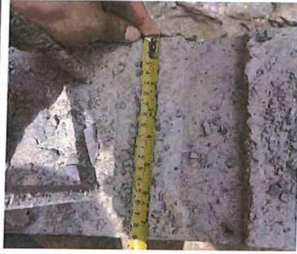
Espesor de muro de concreto armado en captación "Ojo de agua", mide 19 cm.
