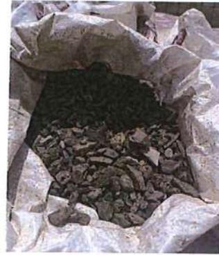
Se evidenció el almacenamiento de agregado fino y grueso en saquetas, sin embargo, los agregados se encuentran parcialmente saturados debido al clima en la zona.
