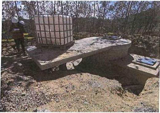
Se observó trabajos ejecutados del reservorio de 5 m3, plataforma para caseta de cloración, caja de válvulas y cámara repartidora de caudales en la localidad de Aduñac Alto.
