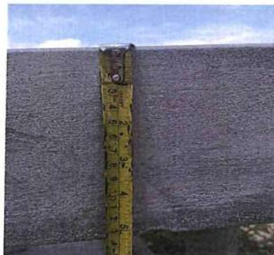
En el reservorio "el Rejo", se evidenció que el espesor de la losa de concreto para la caseta de cloración, tiene un espesor de 13 cm, además se evidencia tarrajeo en mal estado en la parte inferior de la losa.
