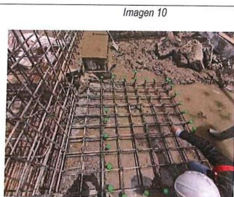
En la captación el chorro, Captación tipo Barraje, el acero inferior de la base de la cámara del vertedero, cuenta con un espacio para recubrimiento de 2.5cm se evidencia un área contaminada, las varillas de refuerzo se encuentran sucias y cubiertas con restos de concreto.
