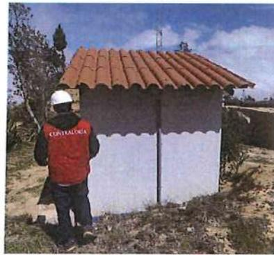
Se evidenció trabajos ejecutados en UBS 1871 y 1876. Donde se observó cobertura de teja andina, correas de 2"x2", viguetas de 2"x3", tubería de ventilación PVC de 2"x2", pintura en muros con esmalte color blanco.
