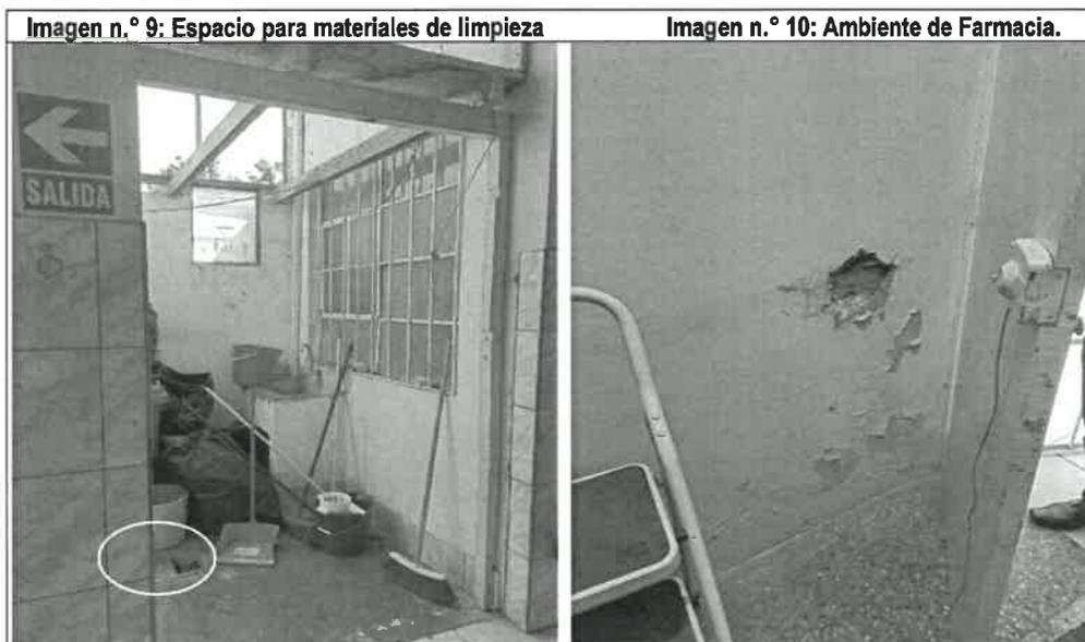
En la imagen n.º 9, se observa que el espacio utilizado para guardar los materiales de limpieza y el acopio de basura, no cuenta con la tapa de buzón de desagüe y en la imagen n.º 10, se observa que detrás de la puerta del ambiente de Farmacia, presente humedad con desprendimiento de la pintura, inclusive del concreto.
