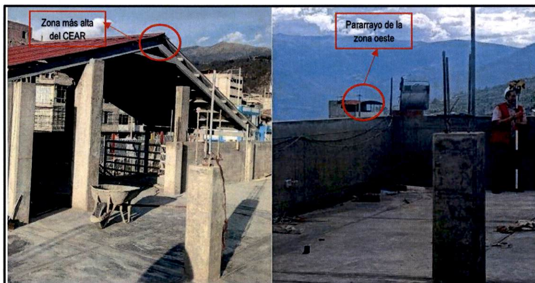
Imagen n.º 6 Zona más alta de techo metálico de la caja de escalera del bloque CEAR
