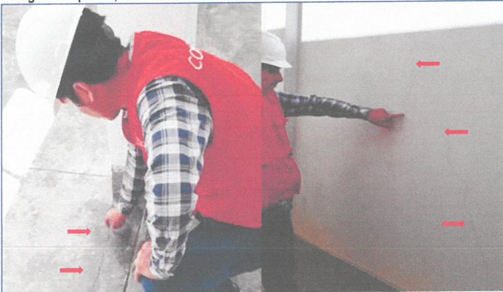
**Descripción:** se verifica fisuras horizontales y diagonales pisos, debido a que se habría producido asentamientos diferenciales, causado principalmente por una deficiente compactación, en el módulo productivo del distrito de José María Arguedas
