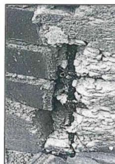
**Descripción:** Base de columna central en vivienda, muestra el acero de refuerzo que no ha sido cubierto con concreto en el proceso de vaciado.
