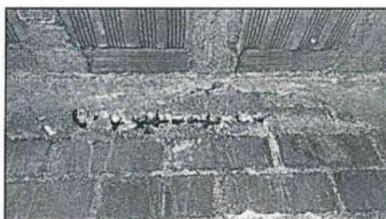
**Descripción:** Viga de amarre de la vivienda, muestra parte del refuerzo de acero, que no ha sido cubierto con concreto, posibilidad de falla por corrosión del elemento.
