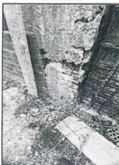
**Descripción:** Columna central de vivienda que ha sido vaciada con concreto, muestra espacios vacíos debido a un mal control en el vaciado, lo que puede afectar la resistencia del elemento estructural.
