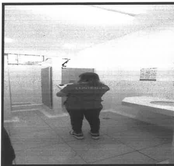
imagen n.º 8 Vestidores no se encuentran acondicionados
