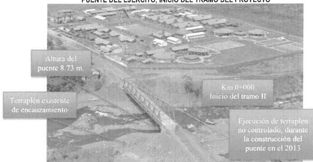
FOTOGRAFIA N° 03 PUENTE DEL EJÉRCITO, INICIO DEL TRAMO DEL PROYECTO
