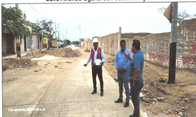
Fotografía n.º 3 Calle Alfonso Ugarte con desmonte y arena
