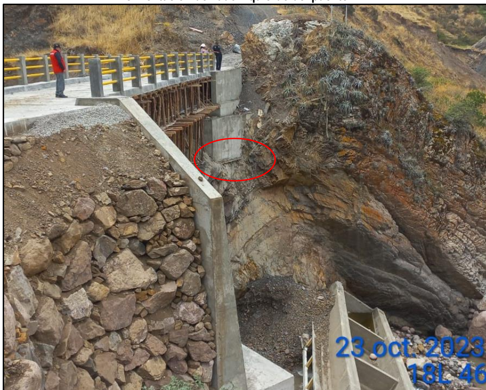
Imagen n.º 12 Cimentación del lado izquierdo del puente.
