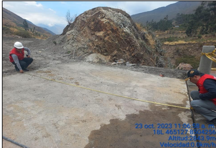
Imagen n.º 10 Medición de la losa de aproximación del lado izquierdo.
