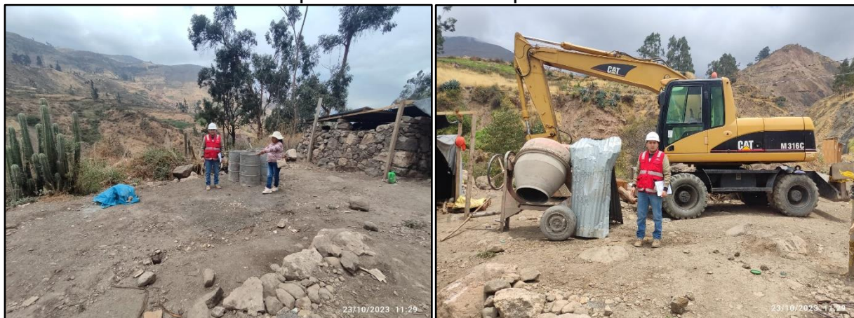
Imagen n.º 4 Área destinada para la instalación de un campamento
