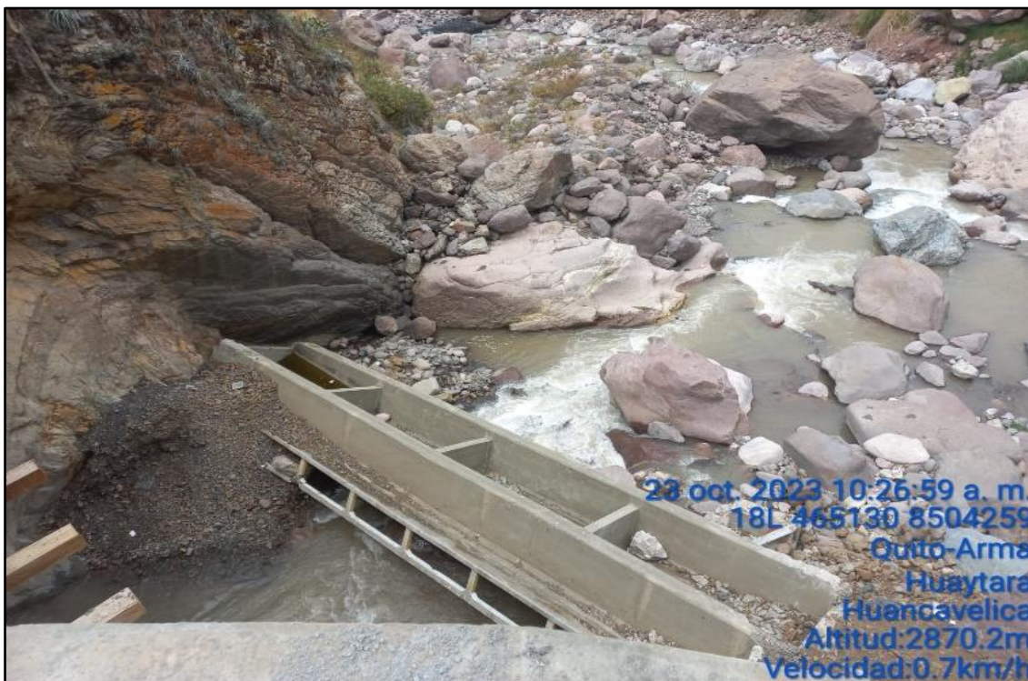
Imagen n.º 2 Estructuras Existente de Concreto Armado.
