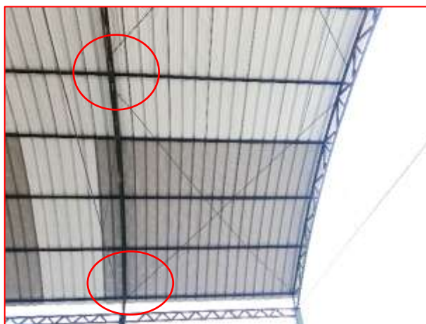
IMAGEN N° 10 TEMPLADORES LISOS FIJADOS MEDIANTE SOLDADURA EN LOS TIJERALES
