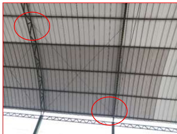
IMAGEN N° 10 TEMPLADORES LISOS FIJADOS MEDIANTE SOLDADURA EN LOS TIJERALES
