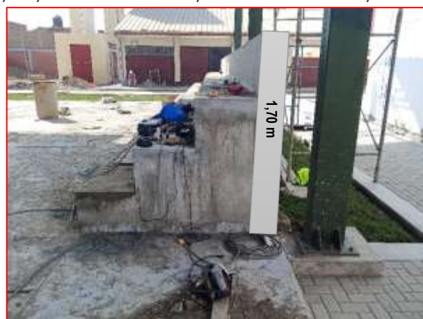
IMAGEN N° 6 SECCIÓN DE GRADERÍA: PASO=0,51M, CONTRAPASO=0,40M, MURO ESPALDAR=0,50M CON ANCHO DE 0,20M.
