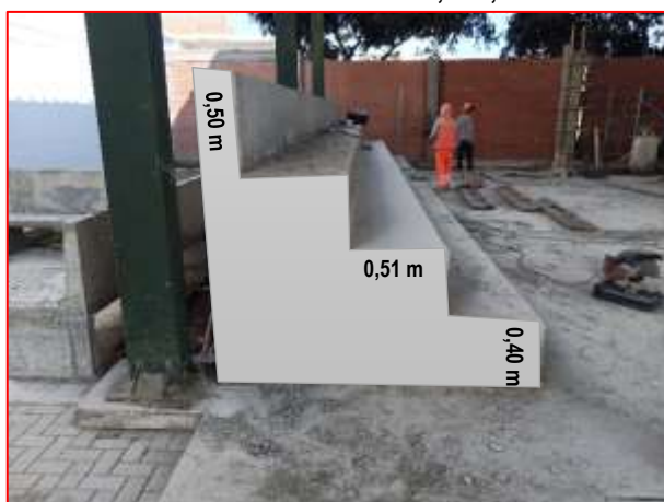
IMAGEN N° 6 SECCIÓN DE GRADERÍA: PASO=0,51M, CONTRAPASO=0,40M, MURO ESPALDAR=0,50M CON ANCHO DE 0,20M.
