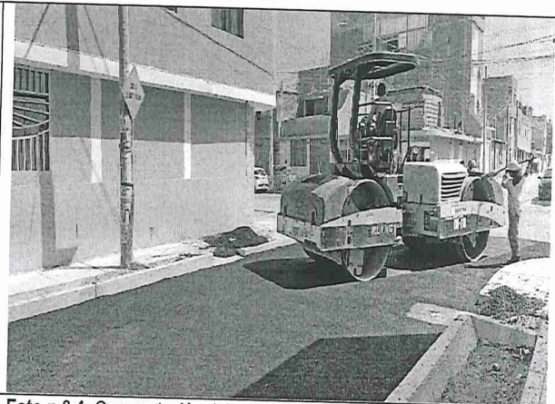
Foto n° 4: Compactación del asfalto con rodillo tandem
