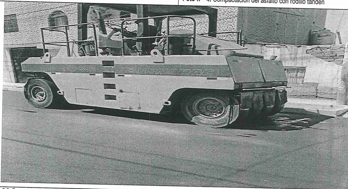
Foto n° 5: Paso del rodillo neumático para el sellado y acabado final de la conformación de la carpeta asfáltica.
