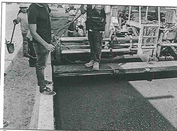
Foto n° 3: Esparcido del asfalto
