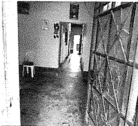
Fuente: Visita de control OCI- 09.03.2023.
