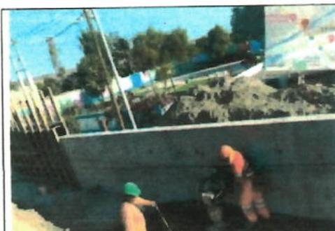
**Fotografía 127:** Vibroapisonador – trabajos en el Puente Palpa.
