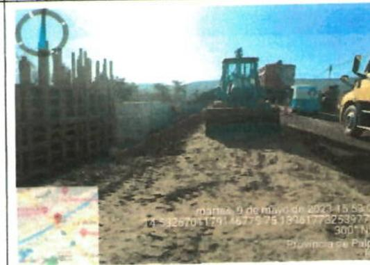
**Descripción:** Se visualiza que vienen realizando trabajo de compactado de la sub base margen derecho, asimismo, encofrado del muro de contención.
