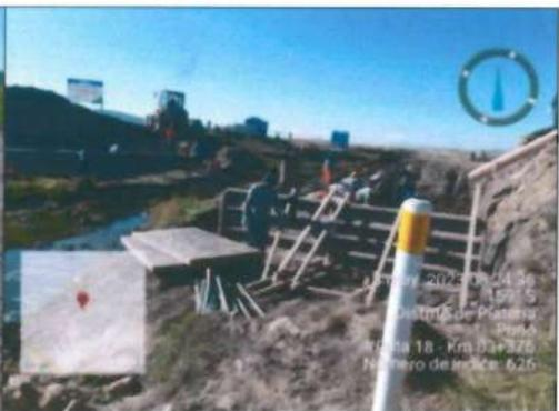
**Fotografía 50:** Trabajos de construcción de un puente modular en la progresiva 03+376 a cargo de la Dirección de Puentes de Provias Nacional.
