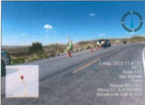
**Fotografía 21:** En el 05+580, se verificó trabajos de reubicación de poste de señalización vertical en el lado izquierdo.
