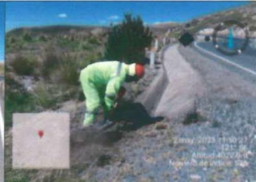
**Fotografía 22:** En el 05+580, se verificó trabajos de limpieza de cunetas y desbroce de vegetación en el lado izquierdo.
