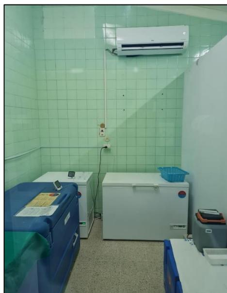
**Imagen n.º 4:** Ubicación actual de los equipos de la cadena de frío, sin sistema de alarma dual de temperatura y corriente.
