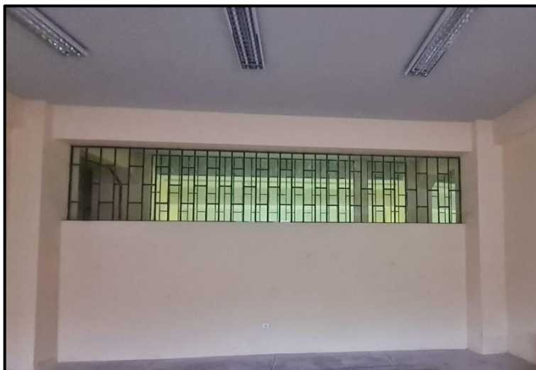
Imagen n.º 2 Ventanas de almacén del PVL
