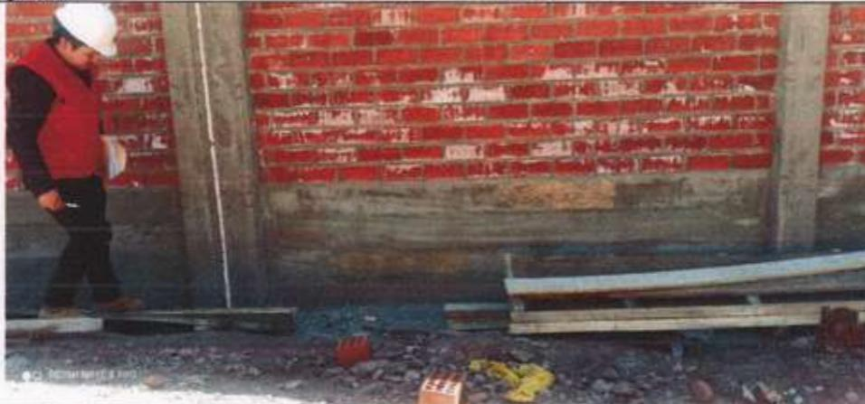
**Fotografía n.º 6:** Vista de residuos de ladrillo, madera los cuales se encuentran dentro del área de circulación de la obra.
