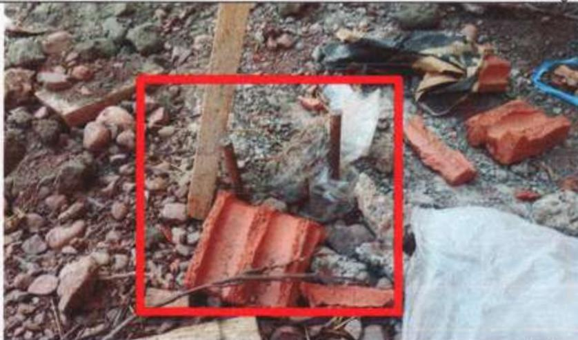
**Fotografía n.º 5:** Vista de residuos de ladrillo, madera, bolsa de cemento, se aprecia dos estacas de acero clavadas, esto es un factor de peligro que puede ocasionar accidentes leves, moderados y graves.
