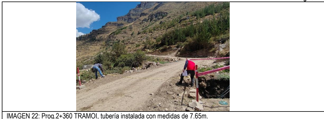
IMAGEN 22: Prog.2+360 TRAMOI, tubería instalada con medidas de 7.65m.
