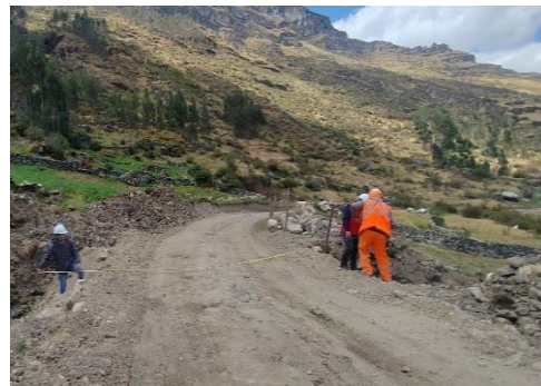
IMAGEN 15: Prog.0+845 TRAMOII, tubería instalada con medidas de 7.65m.
