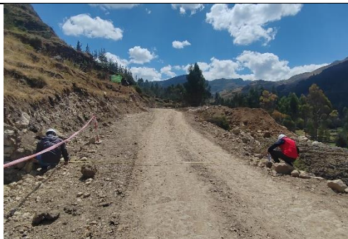
IMAGEN 18: Prog.1+825 TRAMOII, tubería instalada con medidas de 8.64m.
