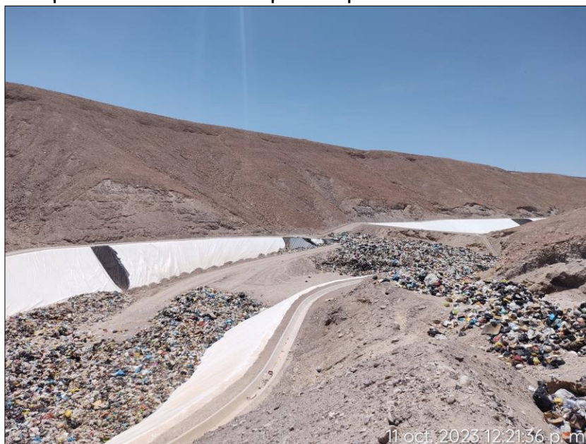
Imagen n.º 12 Residuos sólidos dispersos dentro y fuera de las pozas, no se evidencia que la maquinaria adquirida realice las actividades para la disposición final de los residuos.
