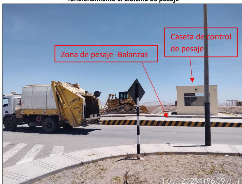
Imagen n.º 14 Camión compactador de 8m³ ingresó sin controlar su peso, debido a que no está en funcionamiento el sistema de pesaje
