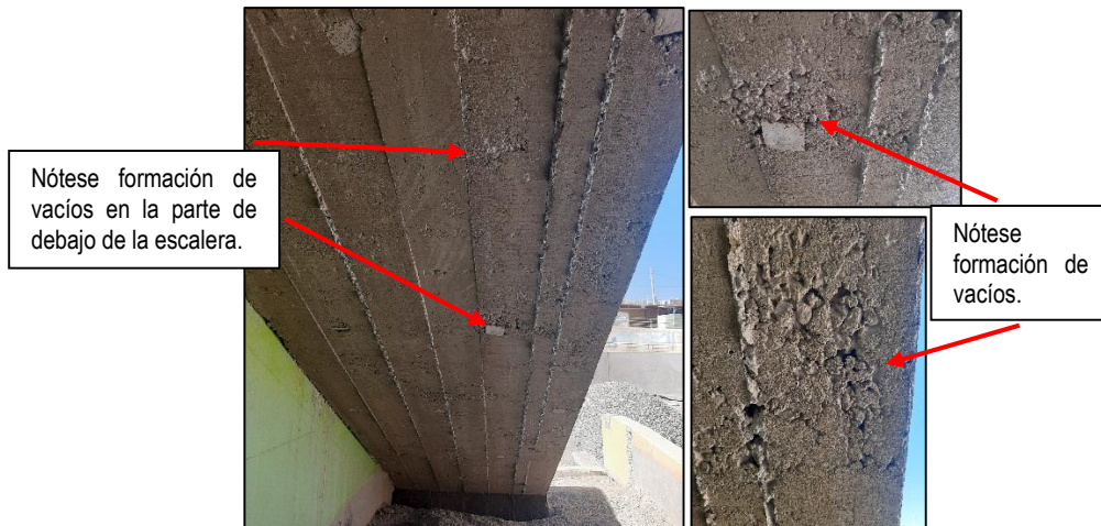
Imagen n.º 32, 33 y 34 Escalera
