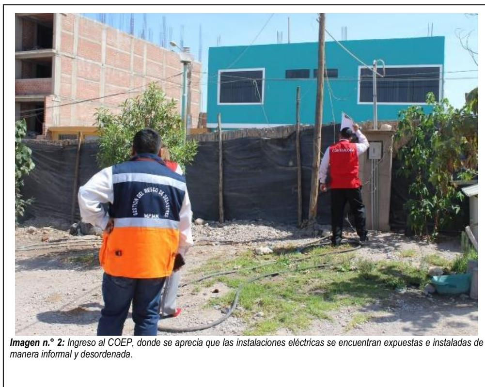
**Imagen n.º 2:** Ingreso al COEP, donde se aprecia que las instalaciones eléctricas se encuentran expuestas e instaladas de manera informal y desordenada.
