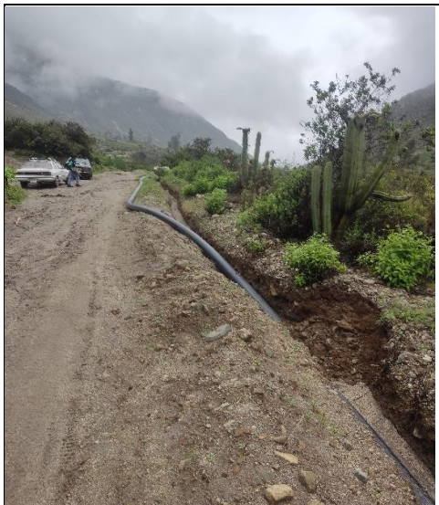
Imágenes n.º 12 y 13 Tuberías HDPE de la línea de conducción expuesta a la intemperie
