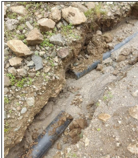
Imágenes n.º 12 y 13 Tuberías HDPE de la línea de conducción expuesta a la intemperie
