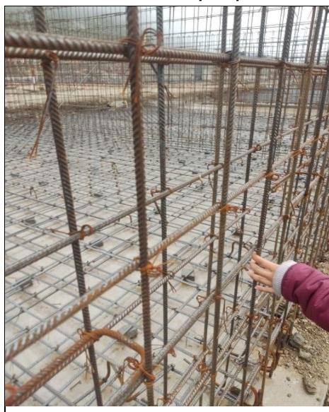
Imágenes n.º 14 y 15 Armaduras de acero de la PTAP en proceso de oxidación debido a las precipitaciones
