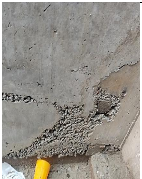
Imagen n.º 1 y 2 Vacíos existentes en los muros del tercer filtro grueso ascendente del PTAP
