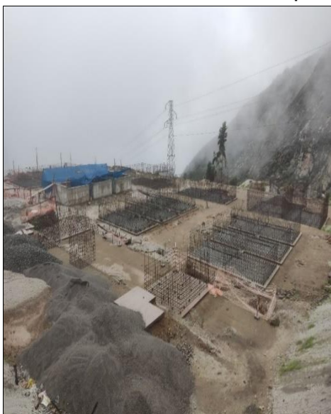
Imágenes n.º 14 y 15 Armaduras de acero de la PTAP en proceso de oxidación debido a las precipitaciones
