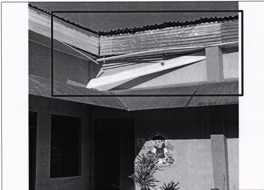
Imagen n.º 11: Deterioro en el techo, lo cual provoca filtraciones en los ambientes internos.
