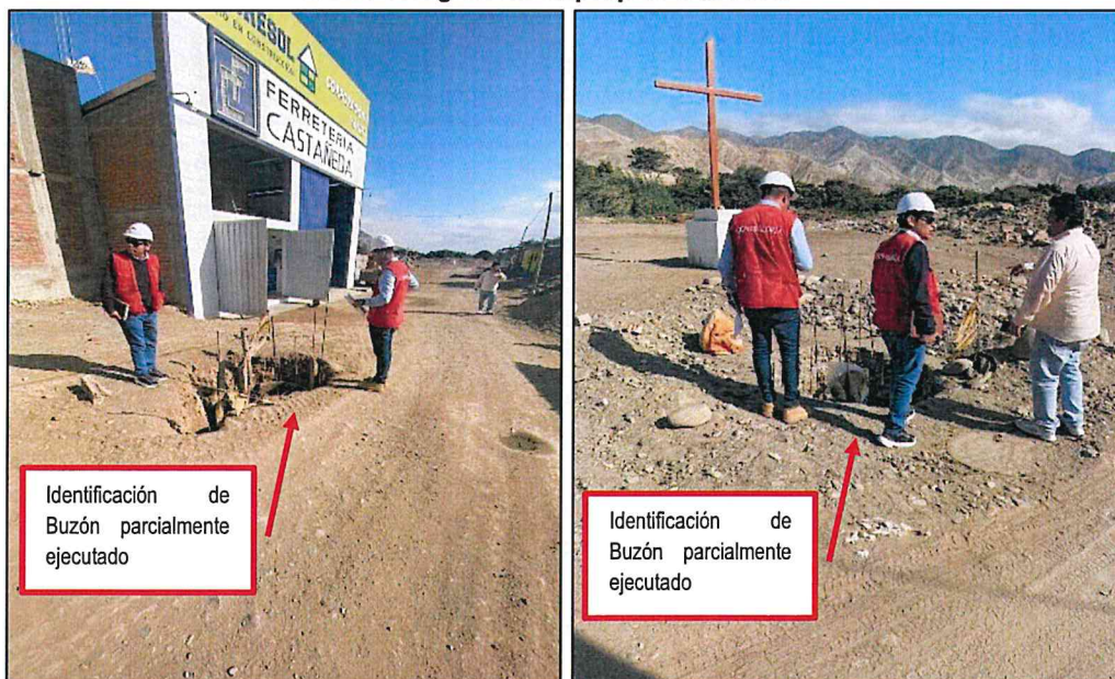
Imágenes n.ºs 22, 23, 24, 25, 26 y 27 Tomas fotográficas impropias a la obra.
