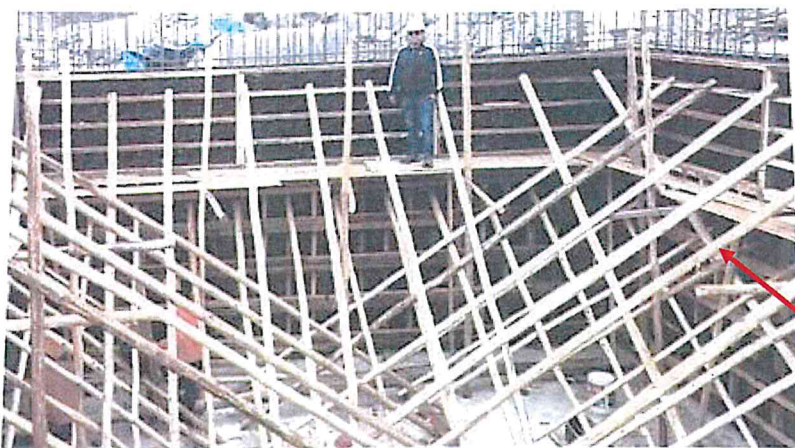
FOTO N° 12: HABILITACION DE MADERA PARA ENCOFRADO EN MURO DE CONTENCIÓN.
