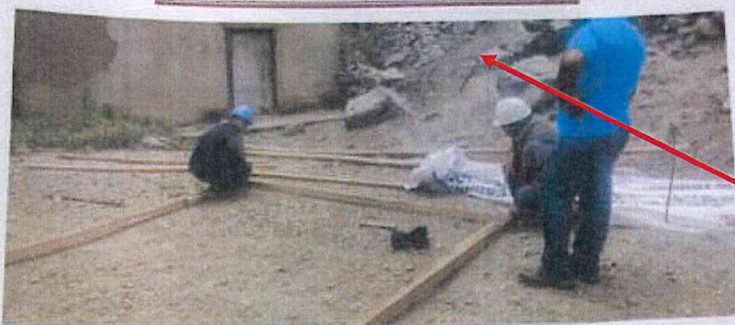
FOTO N° 05: HABILITACION DE MADERA PARA CARTEL DE OBRA
