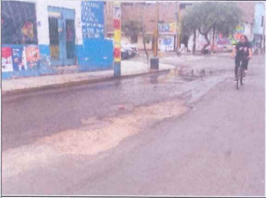
Descripción: Superficie de falla (7.20 m 2 ), se advierte hueco, relleno con material residual y desplazamiento de pavimento.
