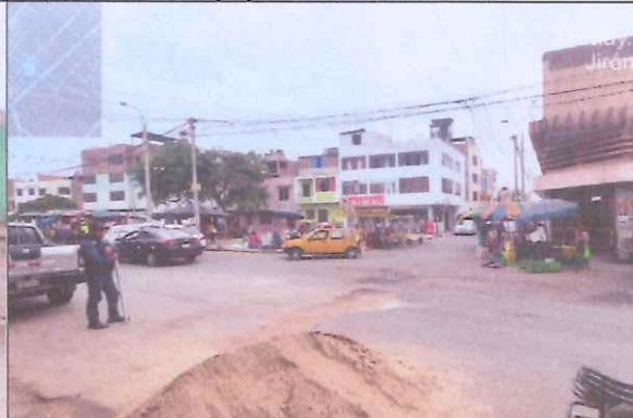
Descripción: Superficie (14.70 m 2 ). Se advierte relleno de hueco con material residual (tierra) por pobladores.
