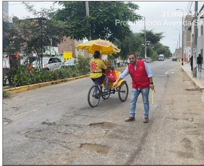
Descripción: Superficie (11.40 m 2 ), existencia de ahuellamiento en bloque.
