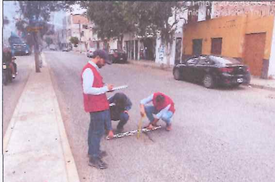
Descripción: Superficie (0.495 m 2 ), la profundidad del hueco es de 0.125 m. Se advierte ahuellamiento.
