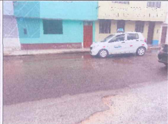
Descripción: Superficie (2.40 m 2 ), se advierte hueco y desprendimiento de agregados.
