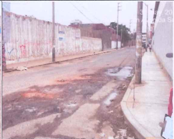
Descripción: Superficie (30.80 m 2 ), se advierte relleno de huecos con concreto por pobladores de la zona.
