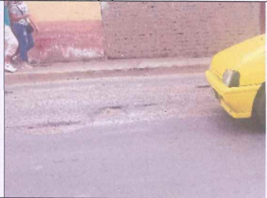
Descripción: Superficie de falla (6.30 m 2 ), se observa huecos y desprendimiento de agregados.
