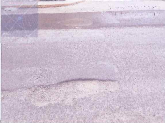
Descripción: Superficie (0.60 m 2 ), se advierte hueco y desprendimiento de agregados.
