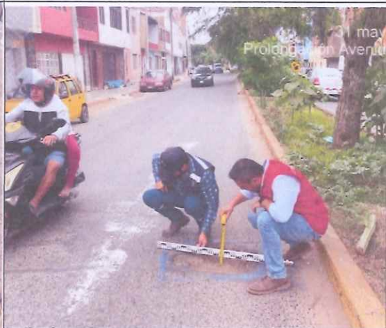
Descripción: Superficie (0.96 m 2 ), la profundidad del hueco es de 0.07 m.
