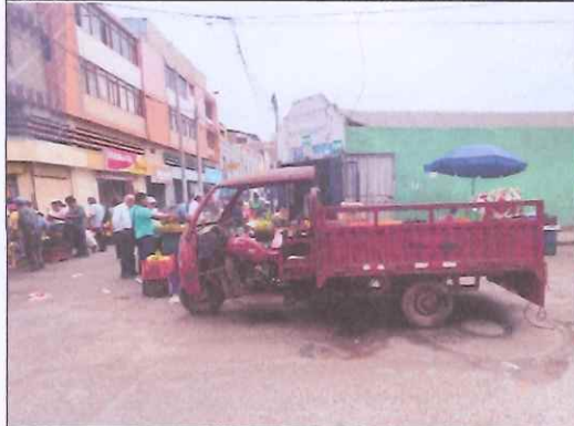
Descripción: Superficie (120 m 2 ) se observan huecos, desprendimiento de agregados, y ahuellamiento.
