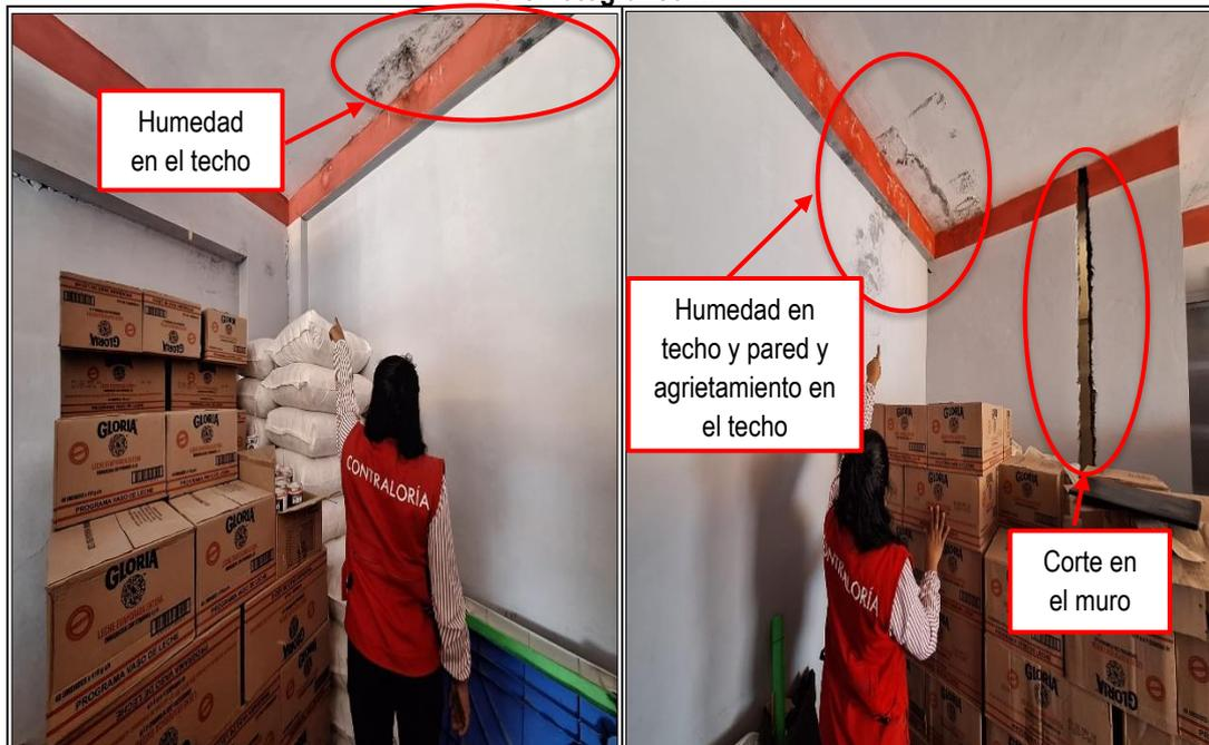
**Imágenes n.ºs 1 y 2:** Se muestra humedad en el techo y pared del espacio destinado para almacen de los productos del Programa del Vaso de Leche y productos del Programa de Complementación Alimentaria, además, del agrietamiento en el techo y un corte en el muro sin reparación.
