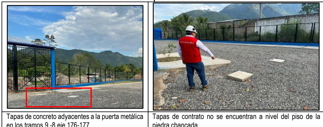
Panel fotográfico n.º 4 Tapas de concreto
