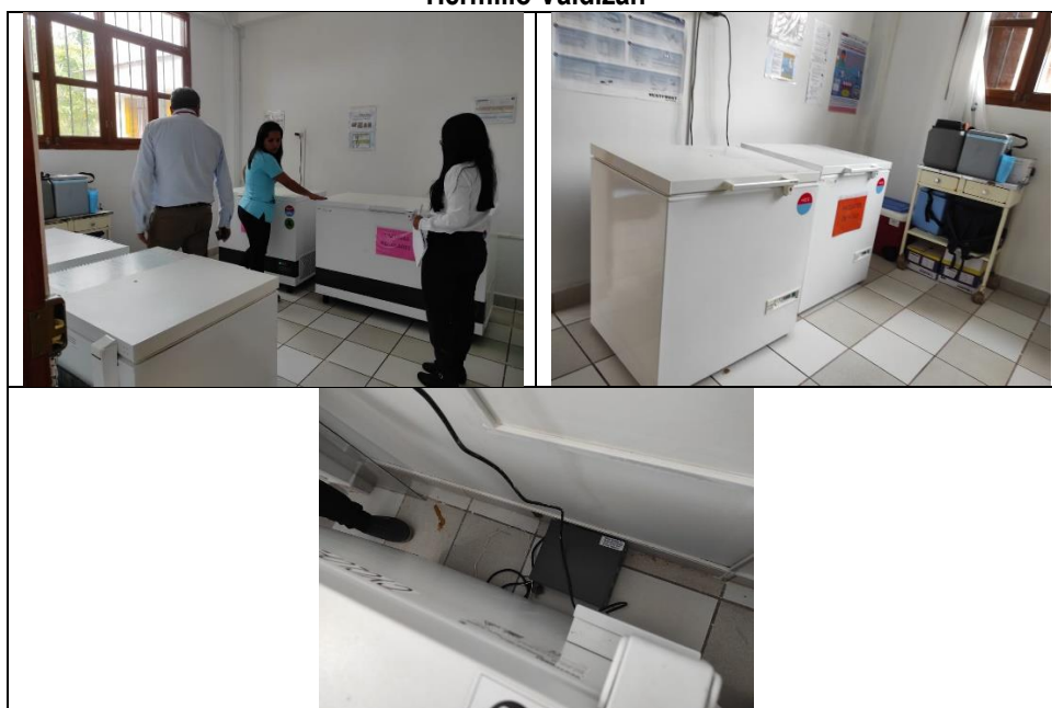
Panel fotográfico n.º 2 Vistas fotográficas de la cadena de frío del establecimiento de salud “Hermilio Valdizán”
