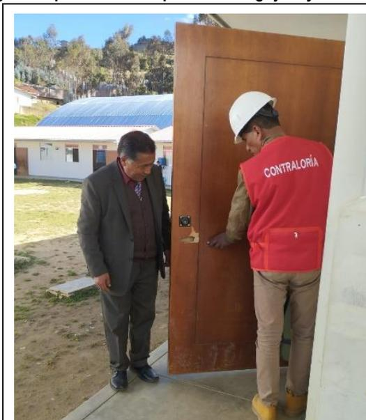
**Imagen n.º 14:** Vista donde se aprecia una de las puertas contra placadas de todos los ambientes que no cuentan con sus jaladores o tiradores.
