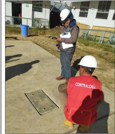
**Imagen n.º 16:** Vista donde se observa la caja de inspección para aguas residuales con tapa de concreto dentro de la losa deportiva.
