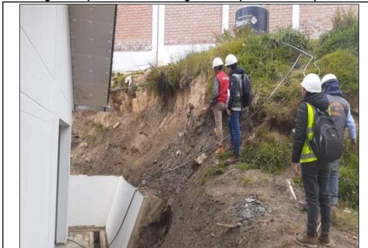
**Imagen n.º 22:** Vista donde se aprecia en la esquina del módulo V el riesgo de colapso del cerco perimétrico, si no se toma las previsiones del caso.
