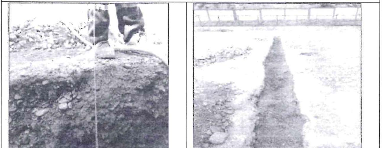
En la fotografía se puede observar, para verificar el sistema constructivo de la zanja de drenaje se excavo unos 50 cm, donde se puede evidenciar, que dicha altura estaba compactado con material afirmado, no estaba como en los planos y presupuestos del expediente técnico, donde indica que el relleno será con gravilla de ¾" a 3".
