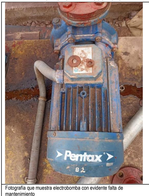
Fotografía que muestra electrobomba con evidente falta de mantenimiento
