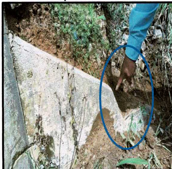
Imagen n.º 12 Aleta de concreto del cabezal – In situ Tramo: Bajo Ihuamaca – La Estrella
