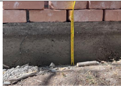
Fotografía n.º 42: Se verificó avances en construcción de sobrecimientos de UBS N° 173, el cual tiene una altura promedio de 28.5cm.
