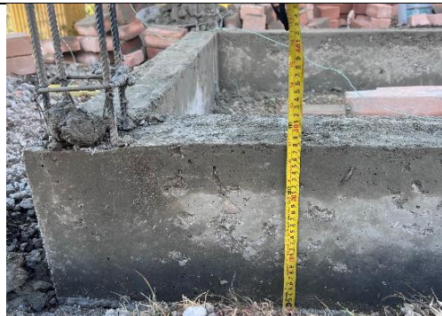
Fotografía n.º 41: Se verificó avances en construcción de sobrecimientos de UBS N°170, el cual tiene una altura promedio de 28.5cm.
