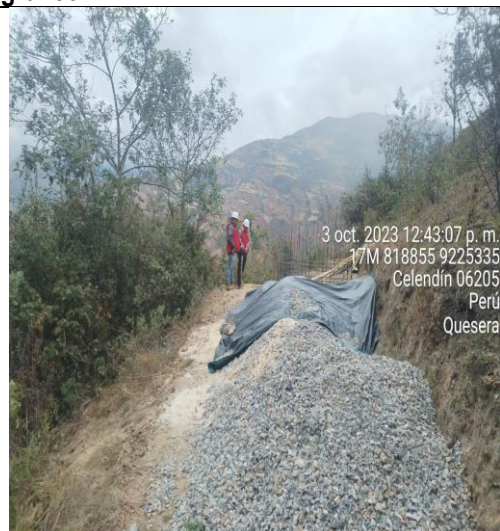
Fotografía n.º2 Comisión de Control inspeccionando el material acumulado en obra.
