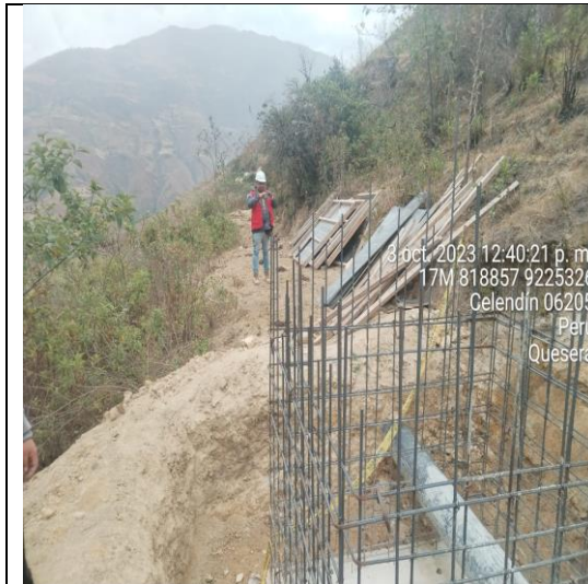
Fotografía n.º3 Comisión de Control inspeccionando el material acumulado en obra
