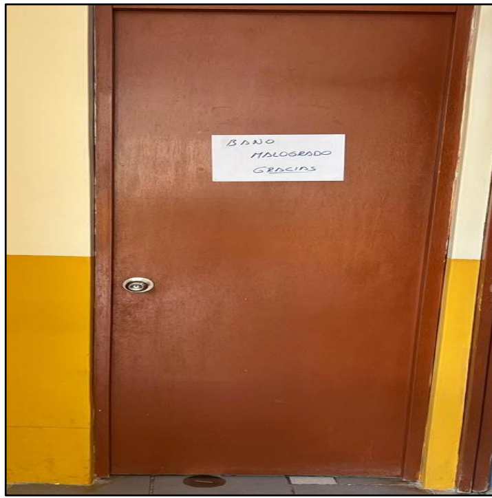
IMAGEN N.º 1 SERVICIO HIGIÉNICO INOPERATIVO
