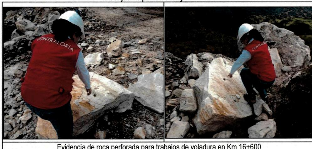
**Evidencia de roca perforada para trabajos de voladura en Km 16+600**
