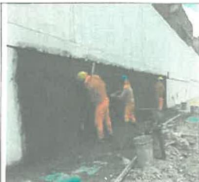
Imagen N° 28: Otra vista de la ejecución de la partida de tarrajeo en paños inferiores del cerco perimétrico.
