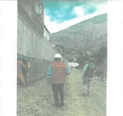
Imagen N° 56: En la vista fotográfica se observa que existen viviendas que colindan con el cerco perimétrico, cuyo drenaje pluvial evacúa por la zona donde se viene construyendo las veredas.
