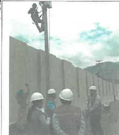
Imagen N° 45: Se aprecia la ejecución de los trabajos de instalación de las cámaras de video vigilancias en los postes instalados.
