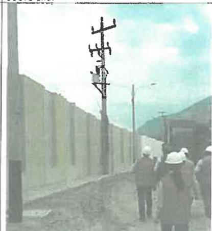
Imagen N° 48: Se observa un poste de media tensión ubicado en la vereda de concreto del cerco perimétrico. No se visualizaron las señalizaciones de seguridad.
