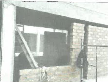
Imagen N° 14: También se observa la realización de trabajos concerniente a las instalaciones eléctricas en la tabiquería para la canalización de los puntos de salida de interruptores y tornacorrientes.
