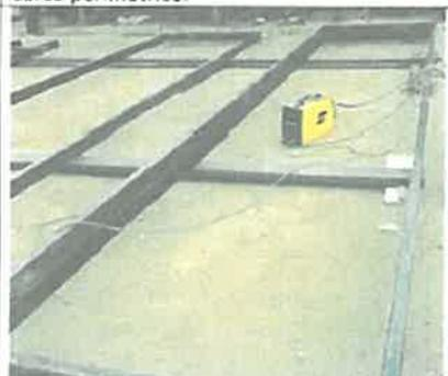
Imagen N° 30: Se puede observar el armado del marco metálico de los portones en obra. Nótese la máquina soldadora.
