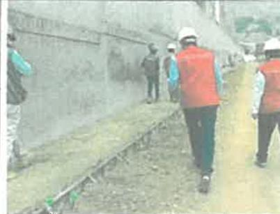
Imagen N° 53: Se observan la habilitación de los encofrados metálicos en veredas.
