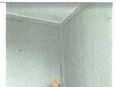
Imagen N° 36: En los puntos de salida donde se van a colocar los artefactos o accesorios eléctricos, se puede observar las cajas de rectangulares de pared y caja octogonal de techo en la cual todavía no se instalaron los cables o conductores.
