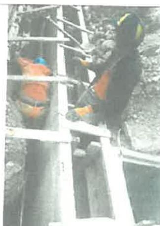
Imagen N° 42: Se pueden observar trabajos de encofrado en canal de drenaje pluvial.
