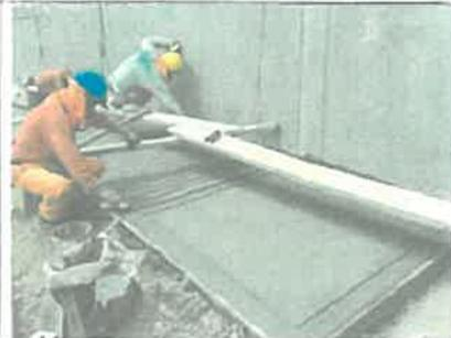
Imagen N° 54: Se pueden observar trabajos de acabado y brufado en veredas.
