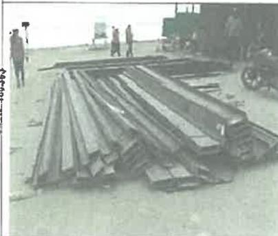
Imagen N° 29: Se observa la habilitación de los perfiles metálicos para la fabricación de los portones de ingreso.
