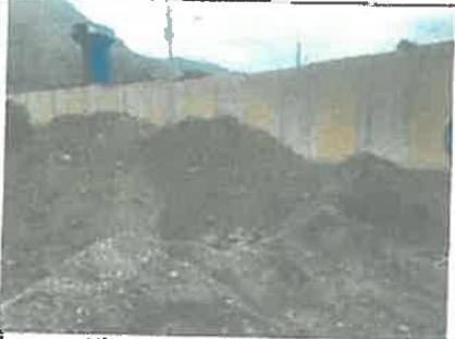
Imagen N° 57: Se puede observar que el material agregado se encuentra junto con el material excedente, lo cual puede provocar que se pueda contaminar el material agregado.
