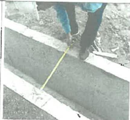
Imagen N° 40: Se verifica la medida existente en campo, respecto a la distancia entre las paredes del canal de drenaje pluvial.
