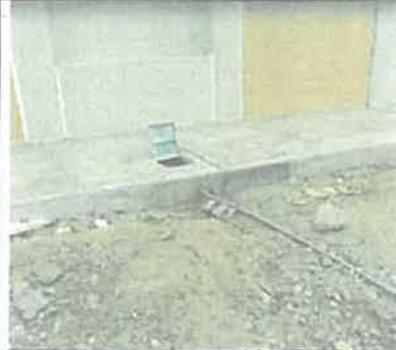
Imagen N° 32: Se aprecia los paños del cerco perimétrico tarrajado, así como también se puede notar la falta de tarrajeo en las vigas de confinamiento.
