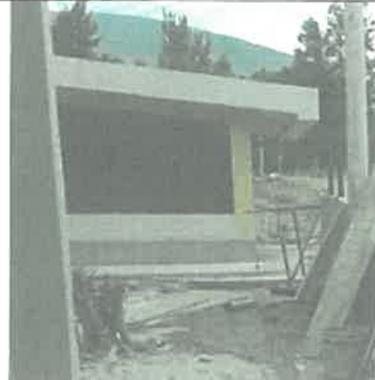
Imagen N° 37: También se observa en la vista que se realizó el pintado de la fachada de la caseta de control, pero que no cuenta con los accesorios de fijación ni el vidrio templado, ni colocación del contrazócalo en la parte externa del módulo.
