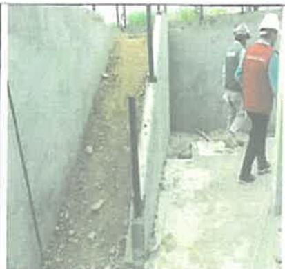
Imagen N° 40: Se aprecia la colocación de la base de afirmado sobre la cual se vaciará el concreto para la ejecución de la escalera de acceso al estacionamiento.
