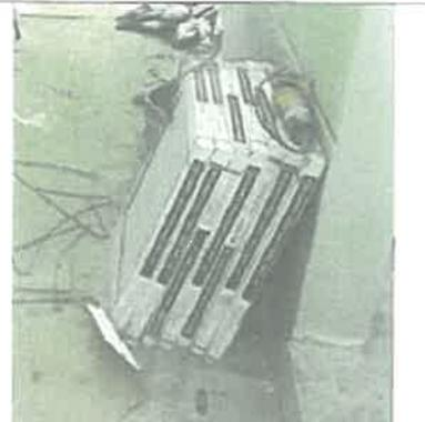
Imagen N° 38: El material empleado para el enchape del piso es el porcelanato 0.60 x 0.60m hueso nano trad 1.4, que no fue colocado aún en su totalidad.
