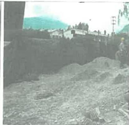
Imagen N° 16: Cerco provisional con parantes verticales de madera con malla arpillera tipo costal colocadas en los accesos a las portadas principales que se encuentran en construcción.
