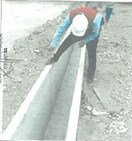
Imagen N° 41: Se verifica la medida de la altura del canal de drenaje pluvial construido en campo.
