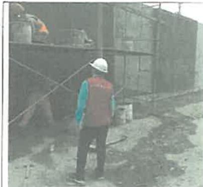
Imagen N° 27: Se puede observar trabajos de tarrajeo en el cerco perimétrico.
