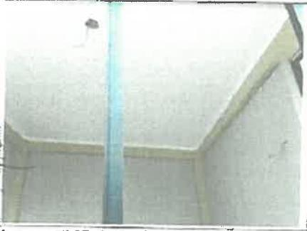
Imagen N° 37: Se verifica la falta de ejecución de instalación de accesorios eléctricos, colocación de vidrios, etc.
