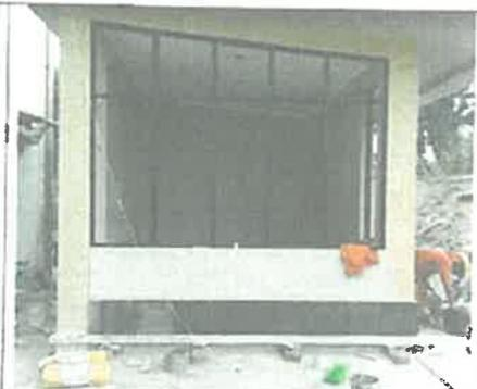
Imagen N° 36: Vista panorámica del cuarto de control televisado. Se observa la instalación de ventana sin terminar.
