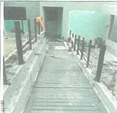
Imagen N° 39: Se observa la rampa de acceso peatonal al estacionamiento y colocación de las barandas metálicas de protección.
