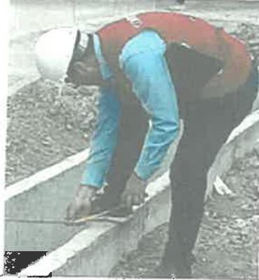
Imagen N° 39: Se observa a la comisión de control verificando las medidas en obra del canal de drenaje pluvial.
