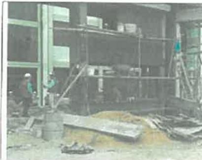
Imagen N° 23 Vista de la caseta de guardiana de portada principal de ingreso n° 2, en la cual se puede apreciar la realización de trabajos en paralelo de asentado de ladrillos y tarrajeo.
