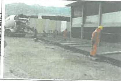
Imagen N° 55: Se puede apreciar el trabajo de vaciado de concreto en losa de estacionamiento y la distribución de concreto correspondiente.
