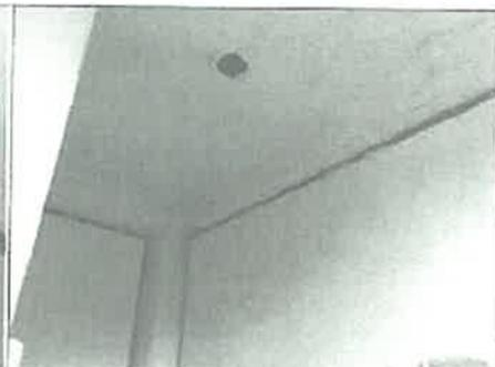
Imagen N° 18: En el mismo ambiente, en cuanto al tema de acabados, se inspeccionó que aún no se terminó con actividades de pintura, ni de instalaciones eléctricas.
