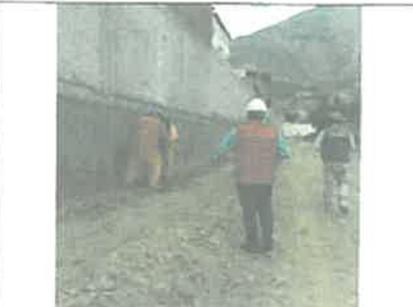
Imagen N° 52: También se constató la ejecución de los trabajos de compactación de la base de las veredas de concreto.
