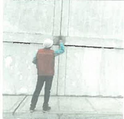
Imagen N° 55: Se puede notar la falta del sellado de juntas en las veredas.
