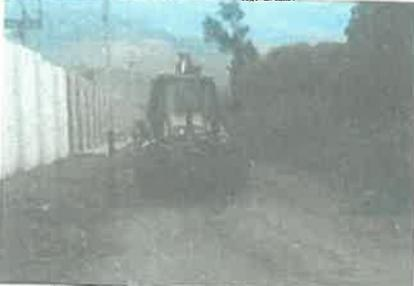
Imagen N° 47: Se aprecia a la maquinaria retroexcavadora trasladando las bolsas de cemento utilizadas para su eliminación.
