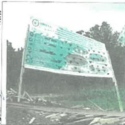
Imagen N° 15: Se observa la existencia del cartel de identificación de obra que se encuentra con una moderada inclinación, propenso a una caída, esta debe ser corregida.
